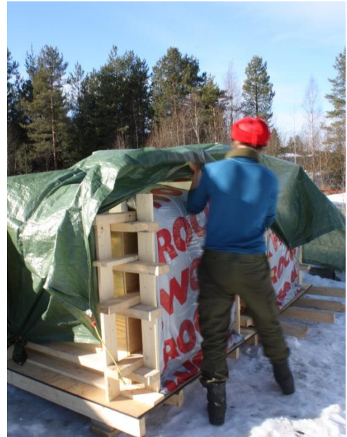
Figur 18: Tildekking av kubikkasser [40]
