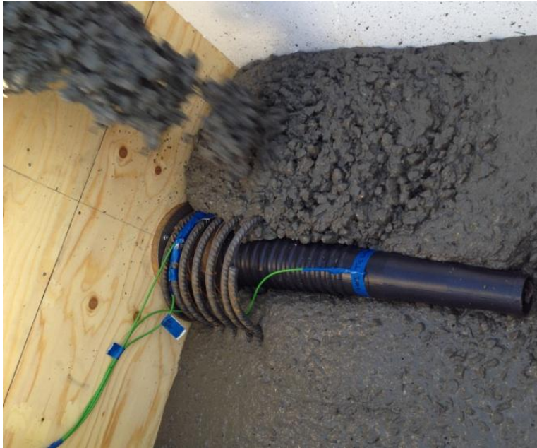
Figur 17: Fylling og plassering av temperaturgivarar i kubikkasse 1 [41]
