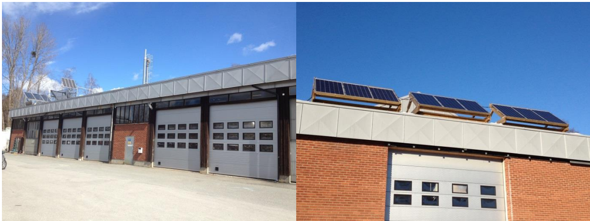
Figur 2.11 viser til venstre fremsiden av Fløy IV, og til venstre vises solcellepanelene som er montert på taket . Foto: Anette Ellingsen.
