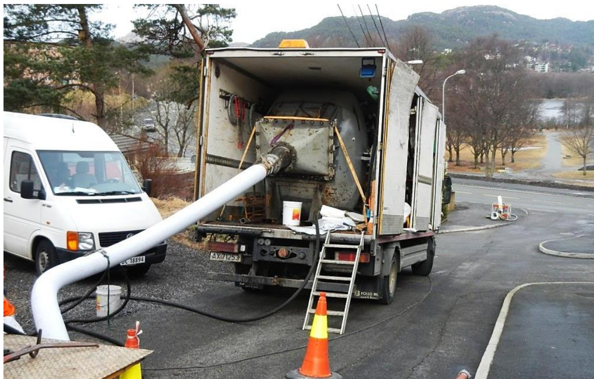
Figur 10 Oversiktsbilde før herding av fóring i avløpsledning
