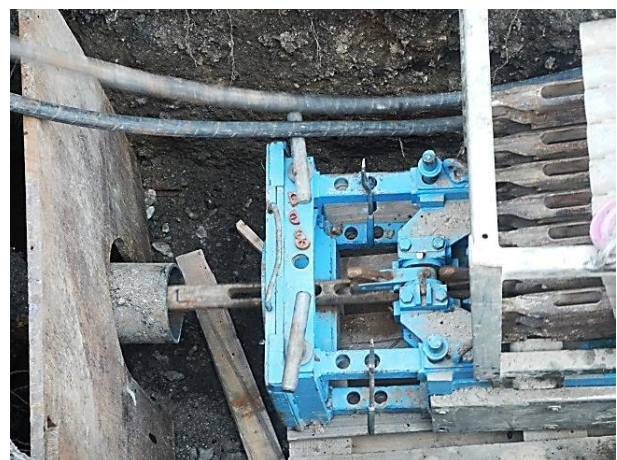
Figur 14 a og b Stag fra hydraulisk jekk (b) er koblet til kuttehodet (a) før utblokking.
