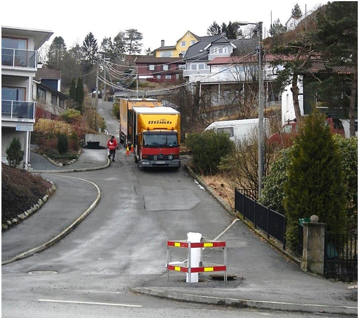
Figur 9 Situasjonsoversikt i veg ved rehabilitering av avløpsrør
