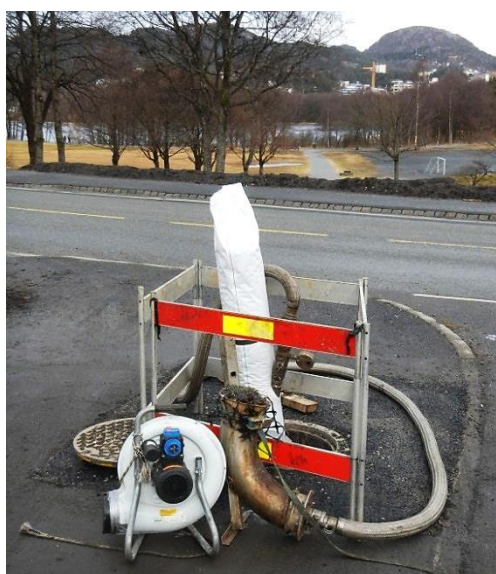
Figur 11 a og b Utstyr for kontrollert utlufting i kum (a). Utstyret i bruk (b).
