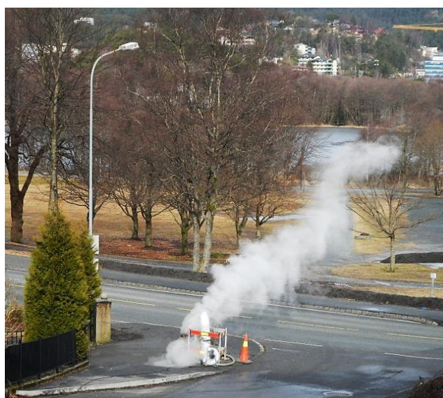
Figur 11 a og b Utstyr for kontrollert utlufting i kum (a). Utstyret i bruk (b).
