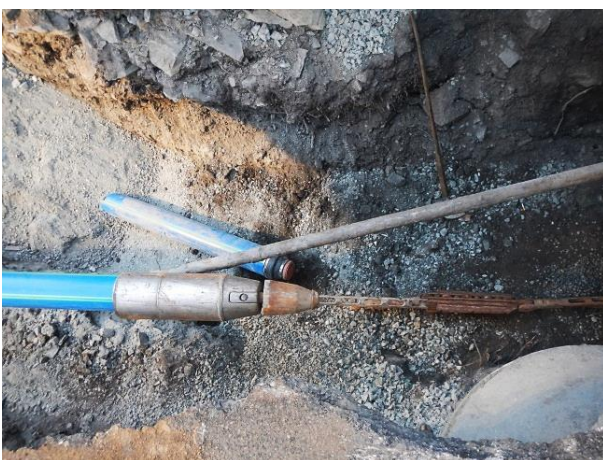
Figur 14 a og b Stag fra hydraulisk jekk (b) er koblet til kuttehodet (a) før utblokking.
