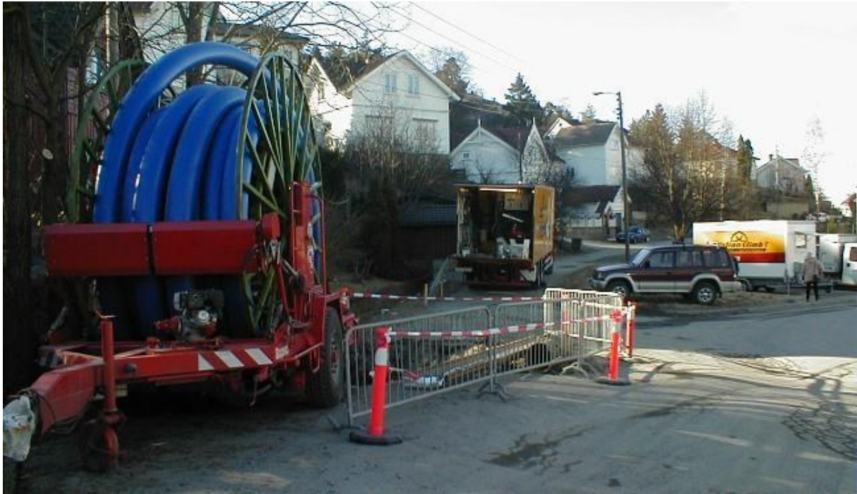
Figur 15 Trommel med tetttilsluttende rør som føres inn i det eksisterende røret (Friberg 2011)
