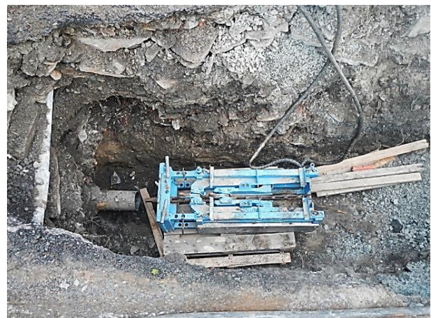
Figur 13 a og b Oversikt over grop for inntrekking av rør (a) og trekkegrop (b) i Sandbrogaten i Bergen.
