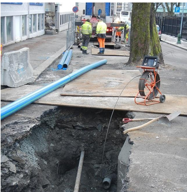
Figur 13 a og b Oversikt over grop for inntrekking av rør (a) og trekkegrop (b) i Sandbrogaten i Bergen.
