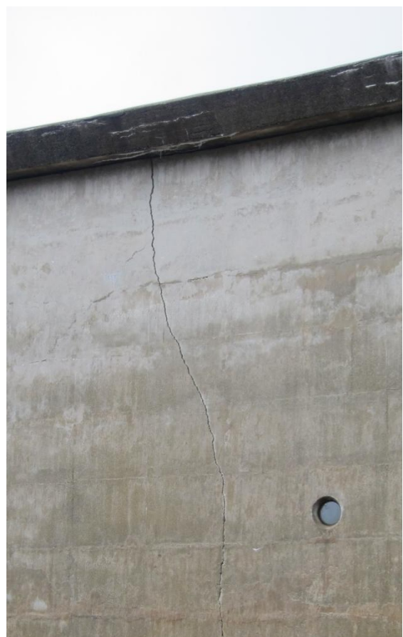
Figur 15 Sprekk i frostvegg som følge av utvidelse av buedam som frostvegg er forankret i.
