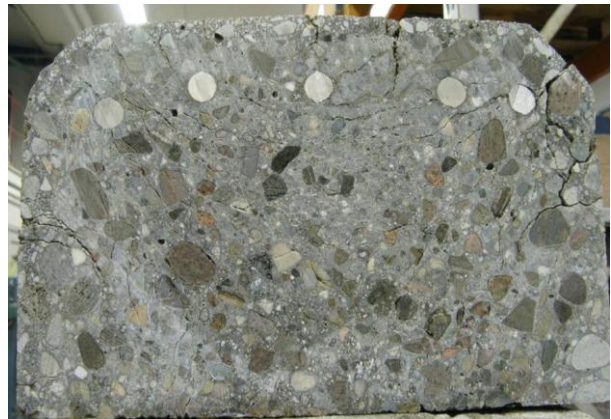
Figur 23 Tversnitt av konstruksjonsdel av Nautesund bru (1)
