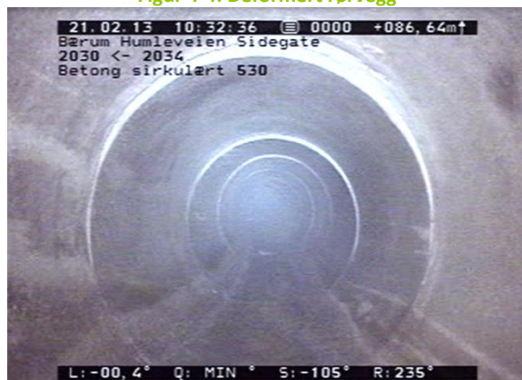
Figur 4-6: Vinkelforskjøvet skjøt
