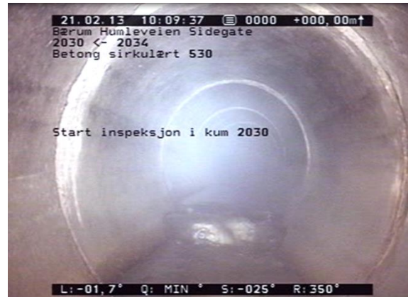
Figur 4-2: Sedimenter
