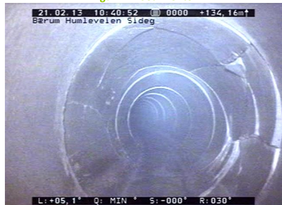
Figur 4-4: Deformert rørvegg
