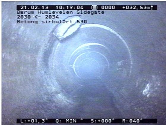
Figur 4-1: Innstukket rør
