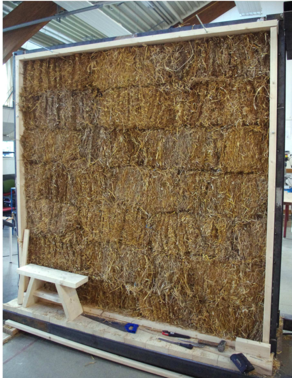
Figur 3.35, over: Halmveggen ferdig stablet, før trimming.
