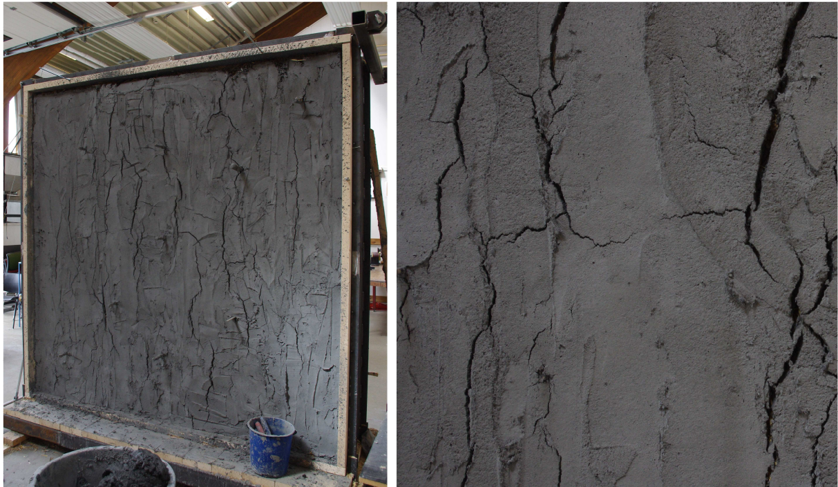
Figur 3.40: Stor grad av oppsprekning i første pusslag. Etter tørking i 14 dager.
