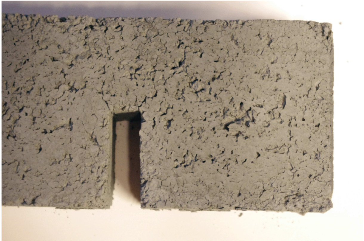
Bilde F1.2: Detaljutsnitt fra prøvens underside.
