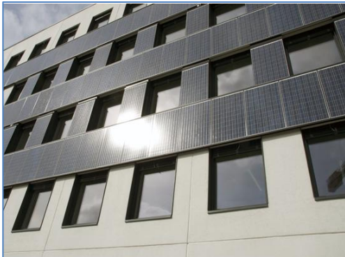
Figur 84 Solcellepanel på fasaden til energibygget Lerkendal [byggaktuelt.no]
