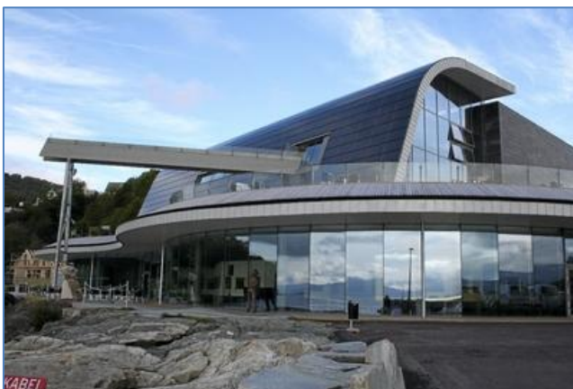
Figur 85 Solcellepanel i taket på Oceania [bkk.no]
