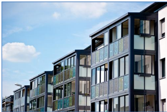
Figur 86 Fargede solcellepaneler på balkong [balco.eu]
