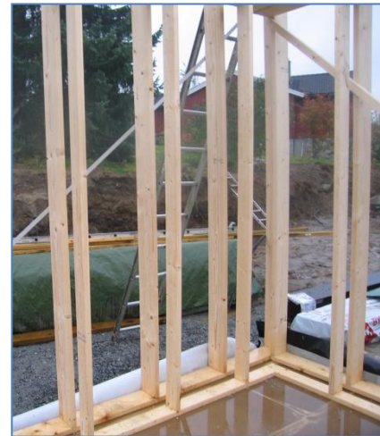
Figur 30 Dobbel bindingsverksvegg [passivhus i Heer, Drøbak]
