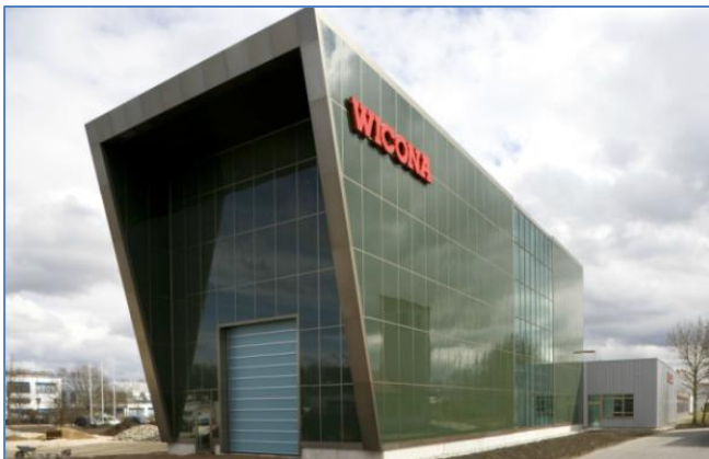
Figur 80 Passivhusbygg med "glassfasade" [wiconafinder.com]
