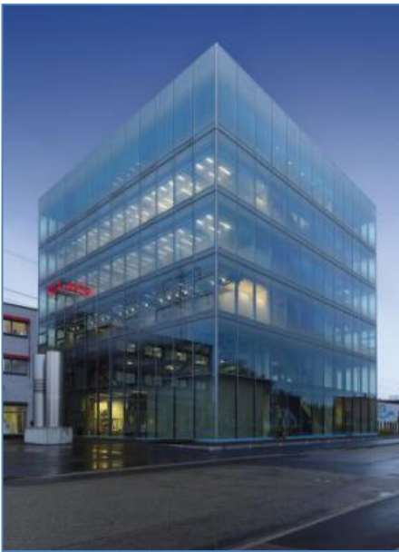
Figur 79 Bygg med WICONA WICTEC FF fasadesystem [alu-profiles.info]
