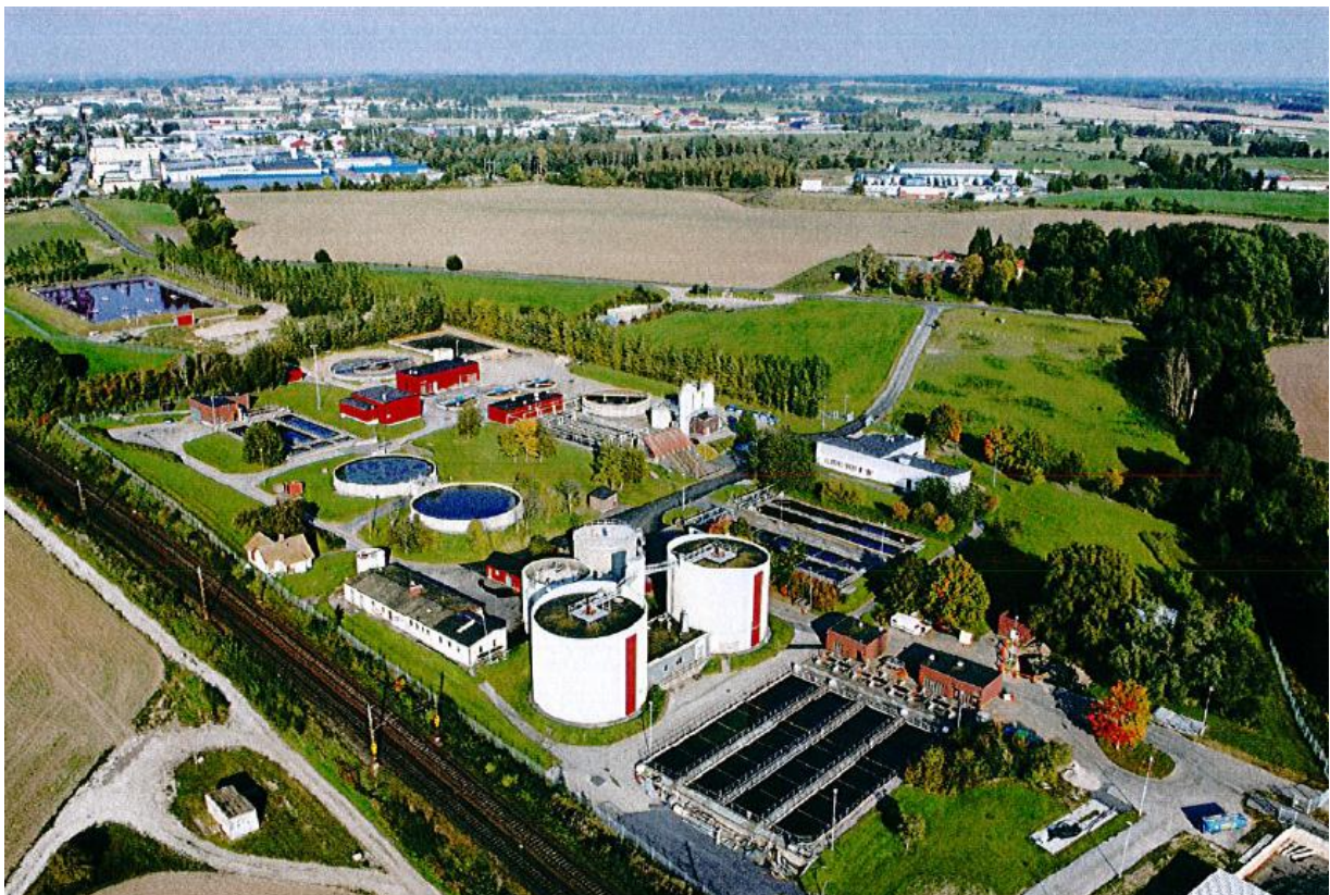
Figur 4.2: Ellinge avløpsrensning, Eslöv. (Fra Ellinge avløpsrenningsverk- miljørapport 2010)
