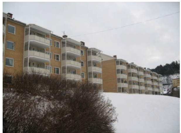
Figur 23 Nabobygningene er lamellblokker oppført i tegl. Foto: Eva V.N.
