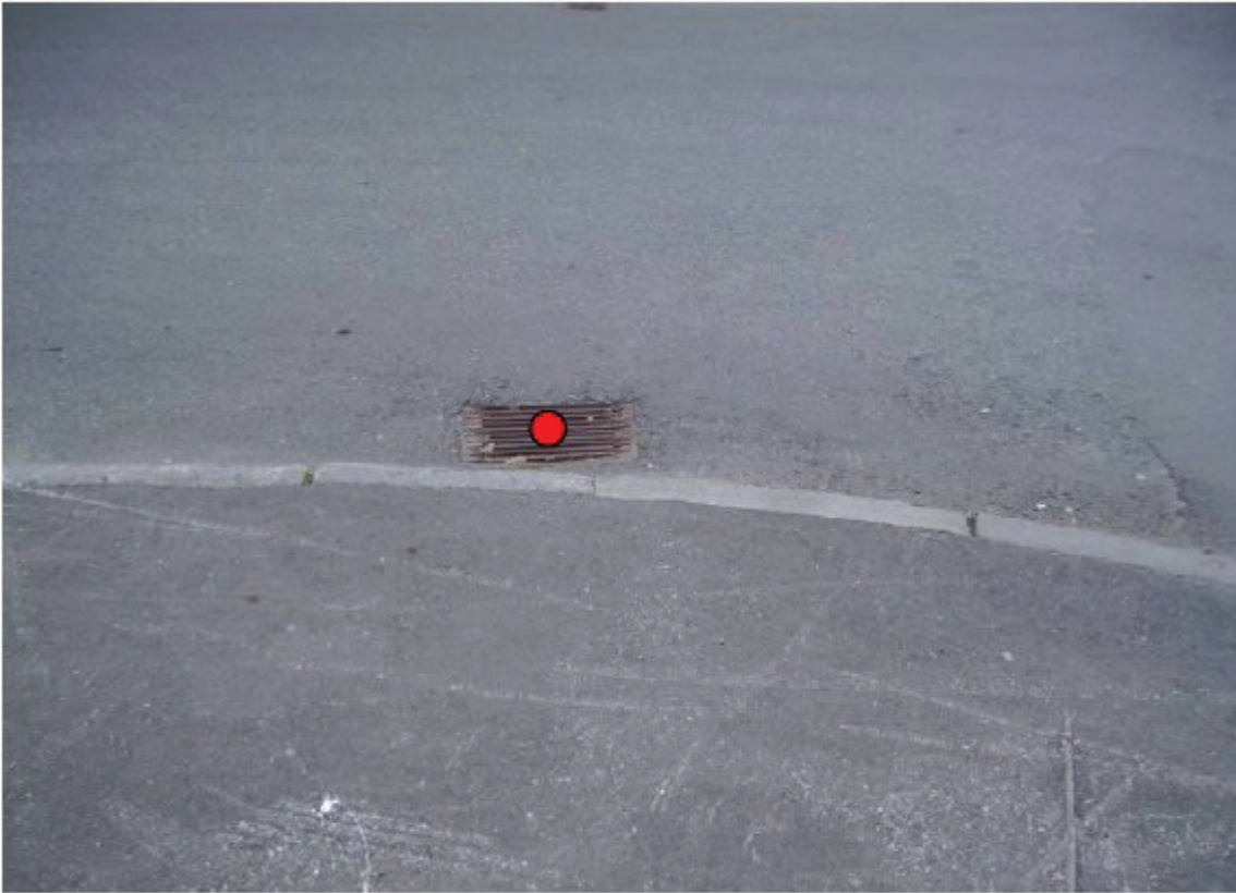
Illustrasjon 18: Illustrasjon av hvordan et sluk registreres. (Statens_kartverk 2011e)
