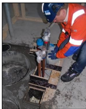
Bilde 5.6. Håkon Brager Larsen tetter rundt rørføringer i etasjeskille.
