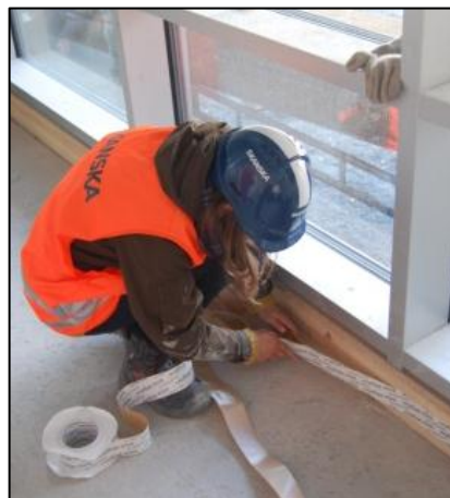
Bilde. 5.11. Tetting med teip av de store utetthetene i sokkelen.
