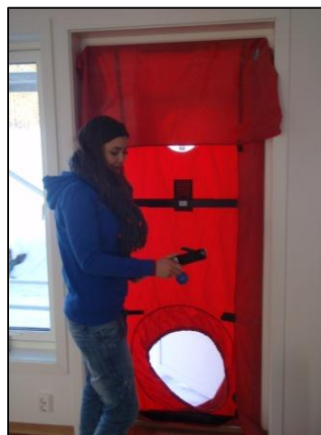
Bilde 4.2. Montering av Blowerdoor før ferdigtest.
