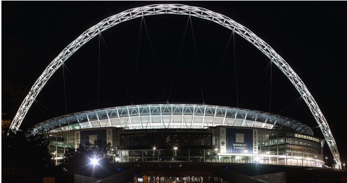
Figur 55 - Buen over nye Wembely Stadium ble løftet på plass med strand jekker, (Wembley Stadium, 2011)
