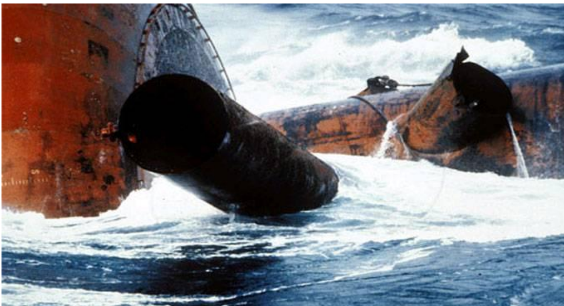
Figur 68 - Utmattingsbrudd i stag D-6 førte til havariet av Aleksander Kielland plattformen og kostet 123 personer livet. Ulykken førte til en skjerping av dimensjoneringskriteriene mot utmatting for offshorekonstruksjoner (SNL, 2009).
