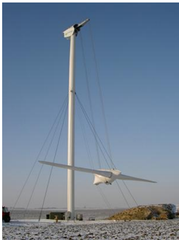
Figur 24 - Viser montering av Vergnet 1 MW vindturbin (Vergnet, 2011).
