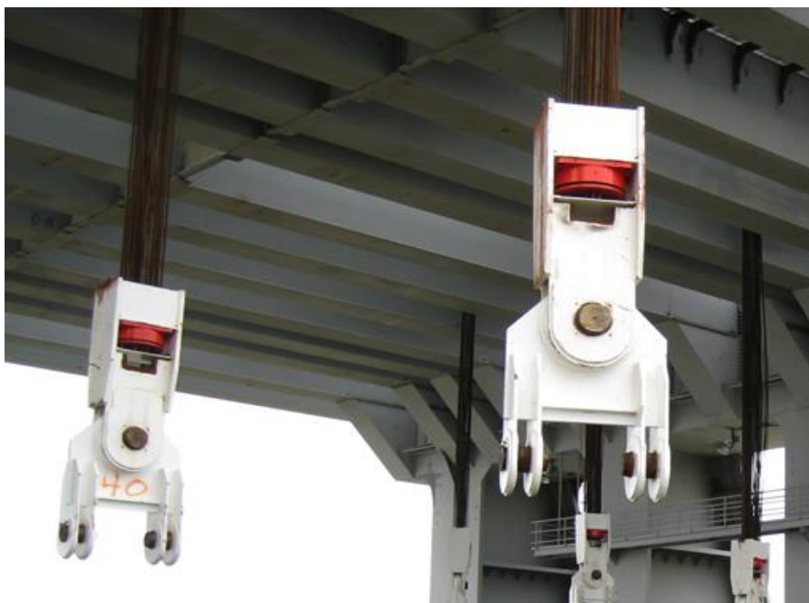
Figur 58 - Viser koblinger der den røde biten er ankeret (Dorman Long Technology, 2011).
