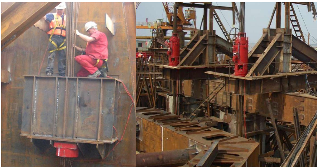
Figur 63 – Viser innfesting av strandjekker (Dorman Long Technology, 2011).
