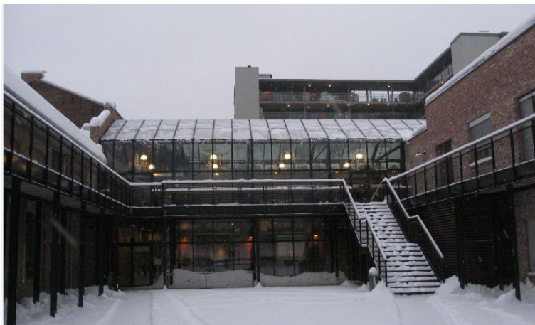
Foto 4: Glass binder teglbyggene sammen. (Skårdal og Strand)
