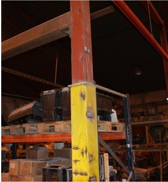
Foto 18: To ulike eksempler på hvordan de nye søylene er montert oppå den eksisterende søylerekka. (Skårdal og Strand)
