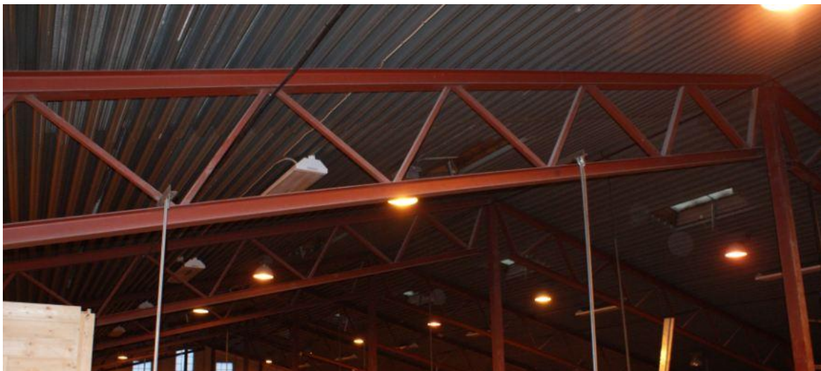
Foto 17: Takkonstruksjonen i Verket. (Skårdal og Strand)
