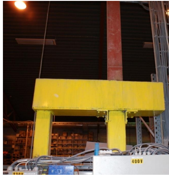
Foto 18: To ulike eksempler på hvordan de nye søylene er montert oppå den eksisterende søylerekka. (Skårdal og Strand)
