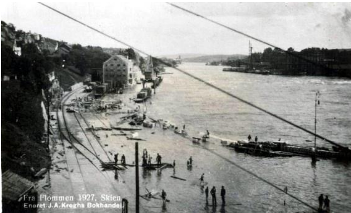
Foto 16: Viser flommen i 1927, her ved langbryggene i Skien som ligger ca. 5 km lenger opp i elva. (Telemarksbilder 2010)
