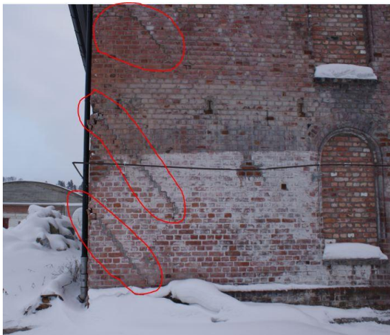
Foto 14: Illustrerer skadene som er på teglveggen. (Skårdal og Strand)
