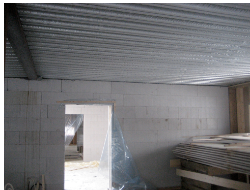
Figure 14: Cofraplus 77 dekkforskaling fylt med 35 kg/m 3 stålfiberarmert betong. 5,2 meter spenn.
