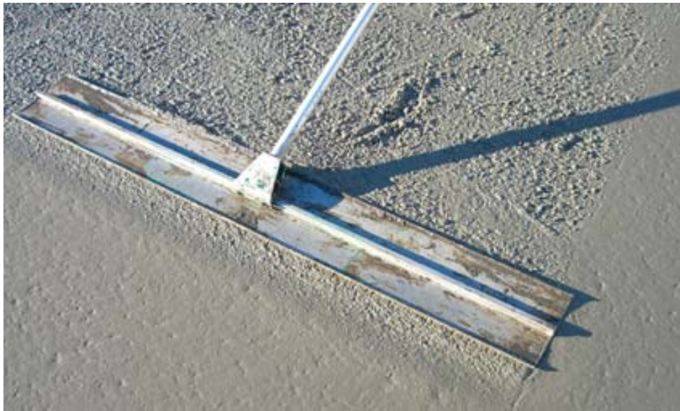
Figure 7: Nyutlagt betongoverflate før og etter dissing. (17)
