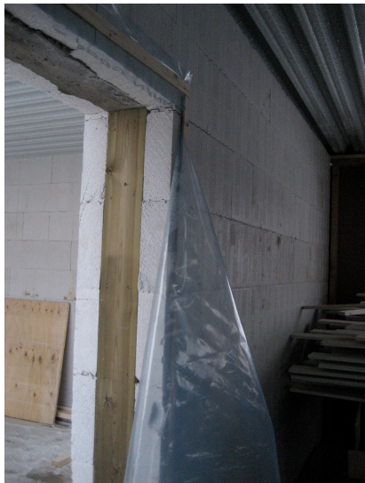
Figure 13: Bewi veggforskaling fylt med med 30 kg/m 3 stålfiberarmert betong.
