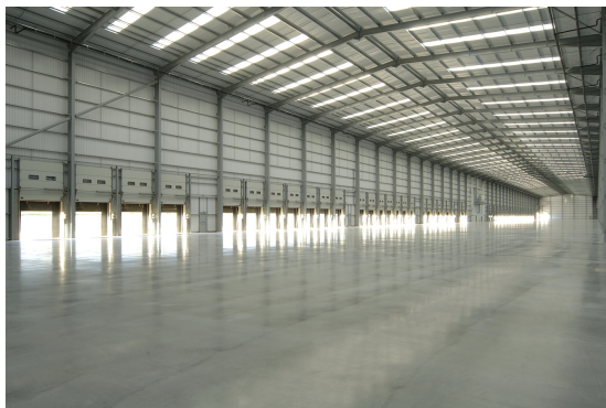
Figure 10: Endelig finish oppnås etter noen runder med pussemaskinen. (19)
