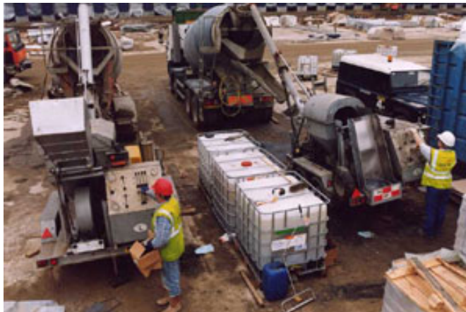
Figure 15: Innblåsing av fiber.(19)
