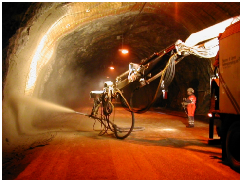
Figure 12: Fjernstyrt sprøyting av tunneltak.(30)
