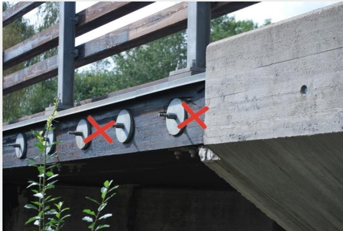
Bilde 35 - Hvor målinger bør gjøres på dekket
