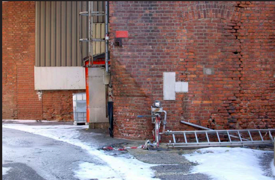
Fig.2.21: Eldste bygningsdel fra jernverket på 1700-tallet: innhuket i hjørnet ga plass til kanalen som rant der asfalten ligger. Gjenmurt vindu i veggen
