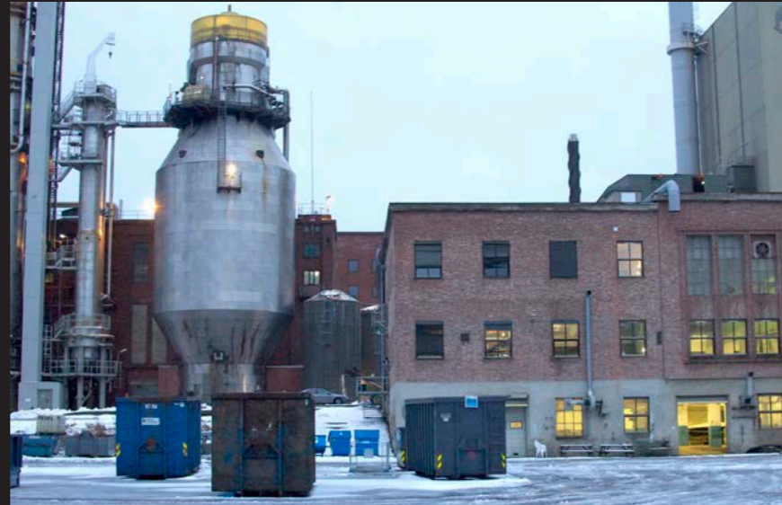
Fig.2.19: Den ca.60 meter høye fliskokeren med en karakteristisk lysende, gul ring på toppen. Verstedshall i tegl i forgrunnen.
