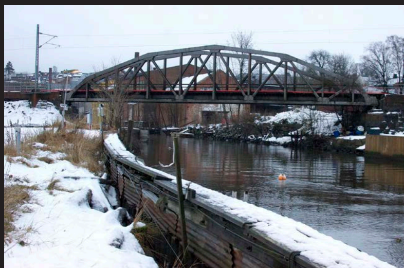
Fig 1.16: Dagens jernbanebru over elven. Kunstig oppbygd elvebredd i forgrunnen for å holde på utfylte masser på Peterson-siden.
