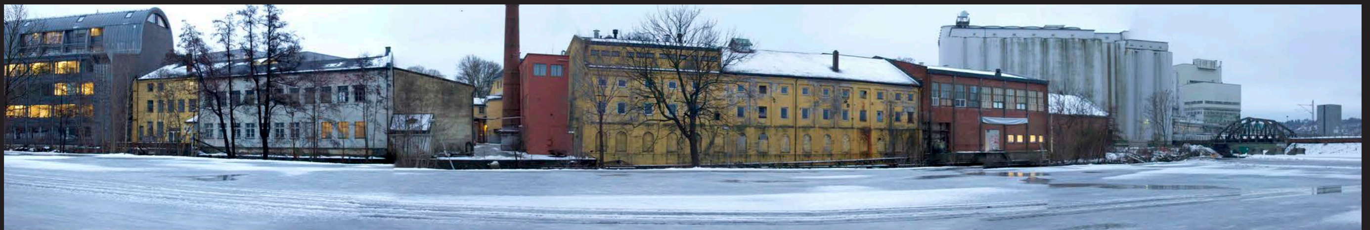
Fig.2.24: Nedre del av Møllebyens sammenhengende fasade mot elven, sett fra prosjektorrådet.
