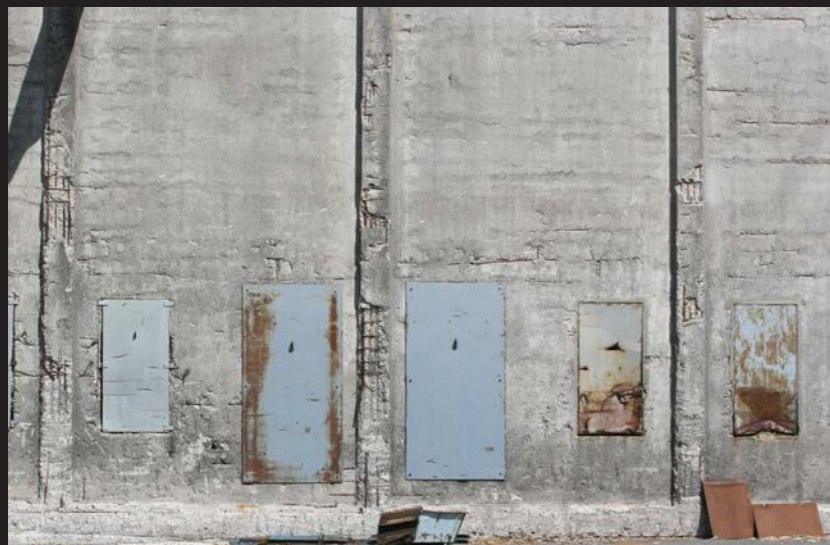
Fig 1.8: Betong, armeringsjern, stålluker. Bak denne veggen sto maskinen som høvlet opp hele tømmerstokker til sagflis.
