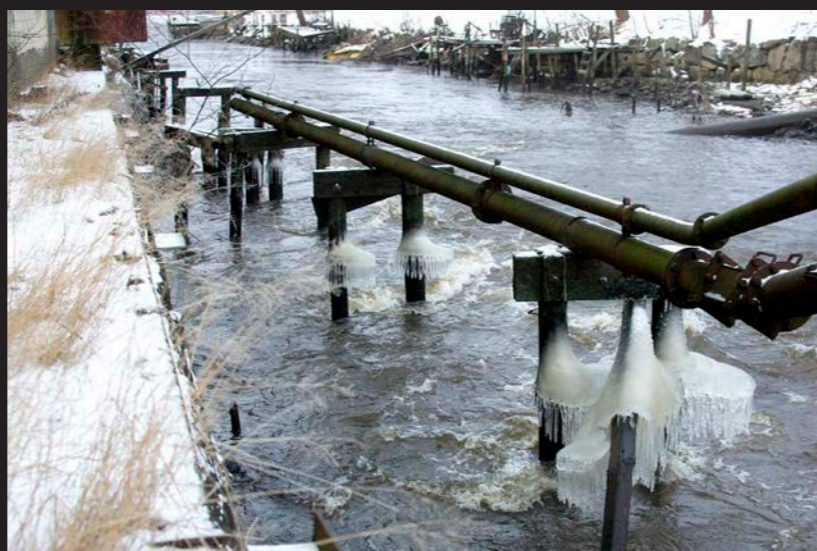
Fig 1.19: Spor etter industri på Mølleby-siden. Rør lagt på påler ute i elven.
