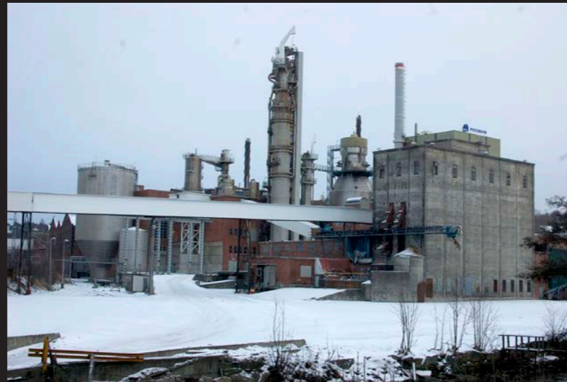
Fig 1.11: Den sydlige siden av fabrikk. Elvebredden i forgrunnen.
