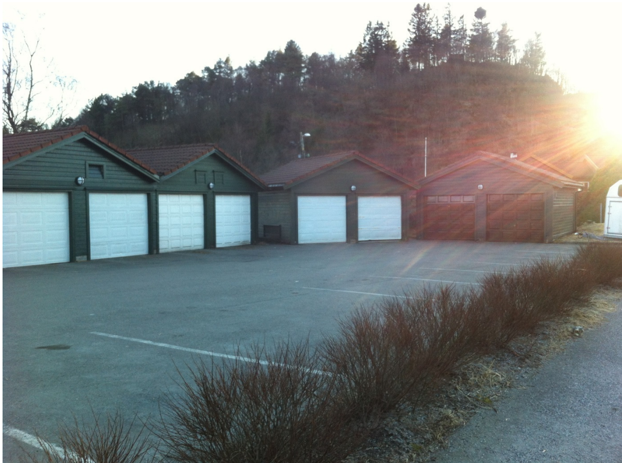
Figur 14: Nokre av dei bygde garasjane på fellesparkeringa på Søreide, (eige foto).
