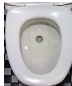
Fig 3.3. Lavspylende vakuum toalett uten urinseparasjon
