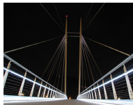
Figur nr. 109 Integriert belysning i håndløpere
