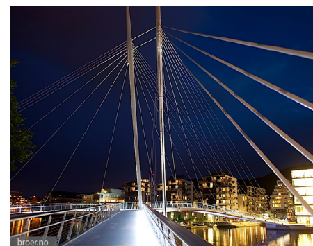
Figur nr. 112 Integrert belysning i håndløpere
