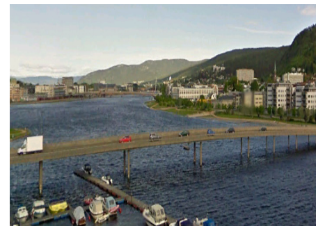
Figur nr. 90 Broen sett fra Motorveibroen
