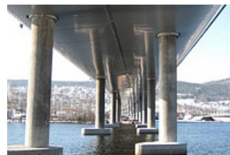
Figur nr. 68 Broens underside med sandwich-plater og søyler
