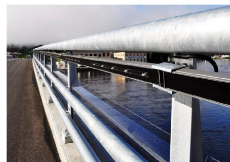
Figur nr. 126 Rekkverk med armaturer
