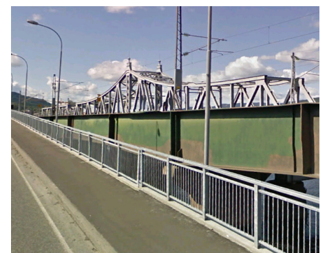
Figur nr. 88 Strømsøbruas fortau med Jernbanebroen i bakgrunn
