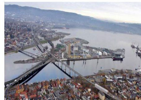
Figur nr. 90 Den komplekse brosituasjonen fra nord-øst
