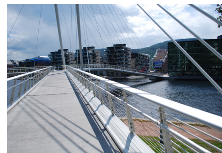
Figur nr. 115 Broens rekkverk og broforløp
