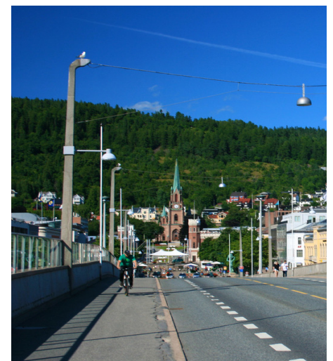
Figur nr. 95 - Broen på nært hold før oppussingen,. Bildet viser også dagens belyningsarmaturer
