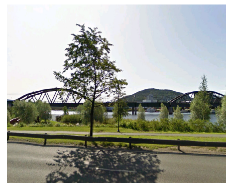
Figur nr. 75 Broen fra Bragernessiden (10m fra motorveibruens underside)
