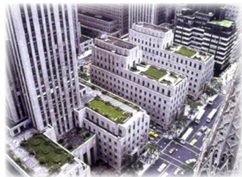
På Rockefeller center i New York ruger et intensivt grønt tak 7 etasjer over bakken. Det grønne taket har eksistert siden 1930 tallet og gir en flott utsikt til de omkringende skyskraperne (Illustrasjon 44).
