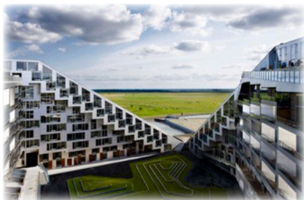
Bilde fra det grønne taket på bygningen 8- Tallet, København (Illustrasjon 3).
