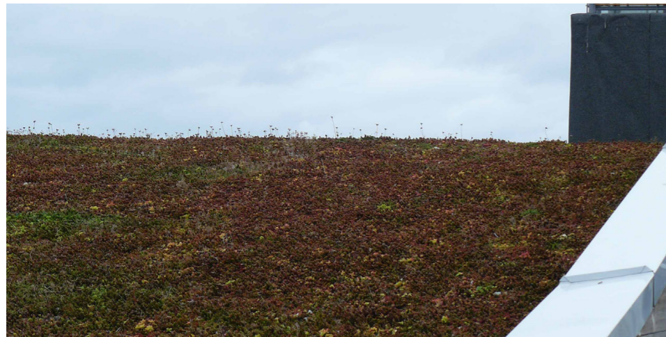
Figur 7 : Ekstensivt grønt tak
