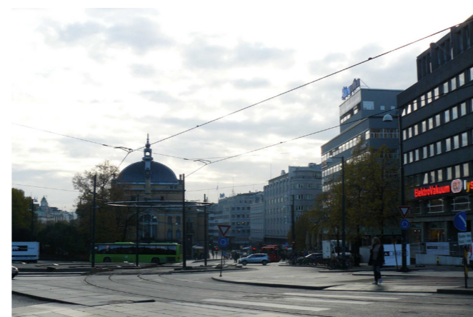
7 Området til høyre sett fra Slottsparken
