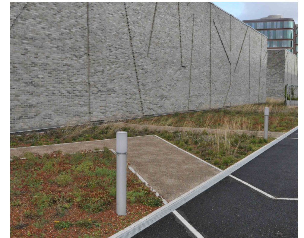
Figur 11 : Semi-intensivt grønt tak på Riksarkivet i København (Foto: Corina Clewing 2010).
