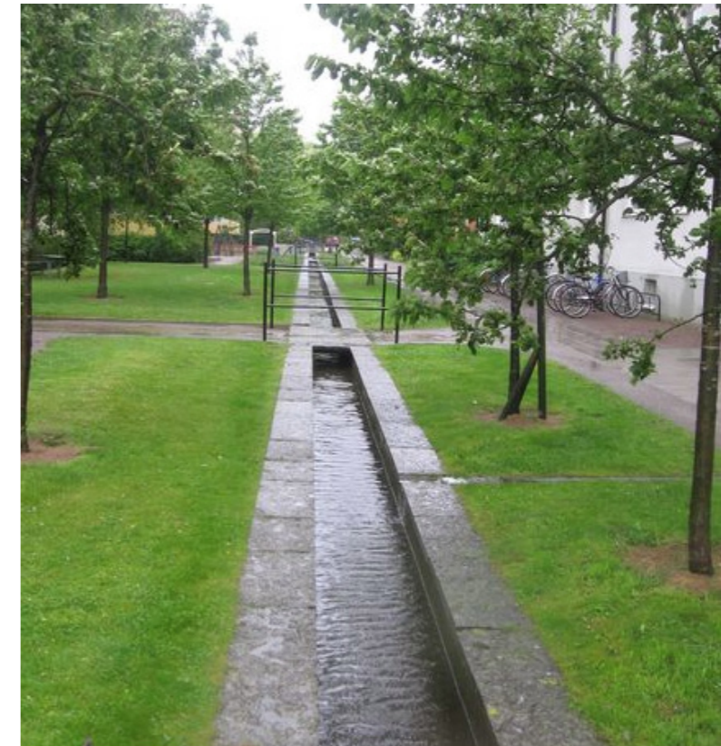
ÅPEN REGNVANNSKANAL GJENNOM AUGUSTENBORG I DANMARK FOTO: HTTP://WWW.KLIMATILPASNING.DK/AKTUELT/CASES/ITEMS/ AUGUSTENBORGKLIMATILPASNINGIMALMOE.ASPX
