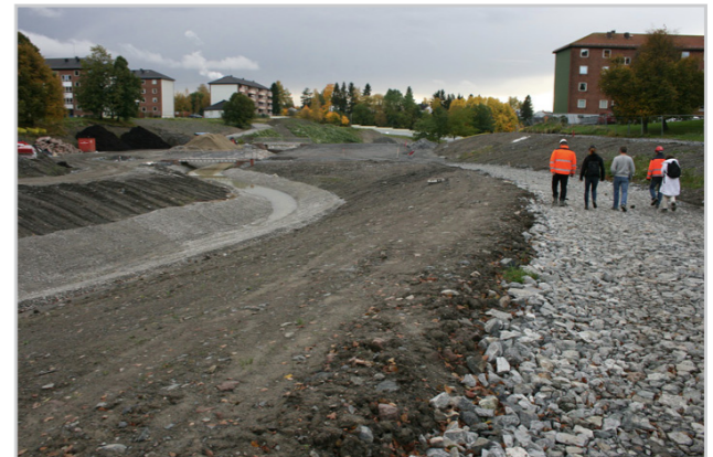
BILDER FRA BYGGEPROSSESSEN, FOTO: DRONNINGA LANDSKAP.
