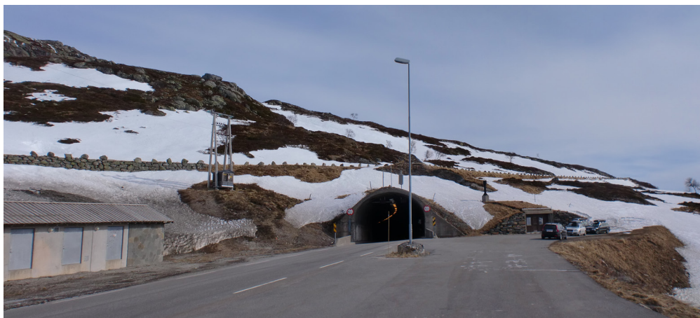
Tunnelen til E134 og gamlevein over fjellet som krysser tunnelen på oversiden.
