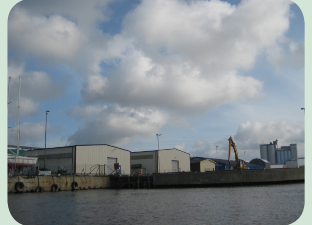
Kaianlegg helt uten vegetasjon
