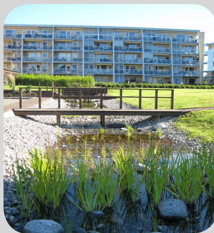
Fordrøyningsbasseng for håndtering av overflatevann
