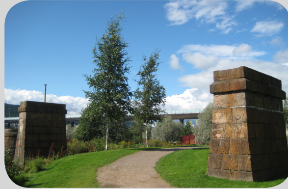
Gamle brofundamenter er bevart som en del av anlegget
