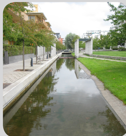
Overflatevannet ledes blant annet ut i noen av vannanleggene i Hammarby Sjöstad
