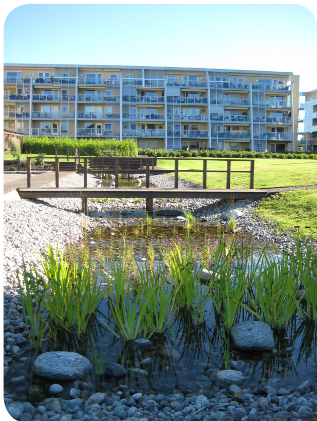
Fordrøyningsbasseng, Elveparken i Lillestrøm
