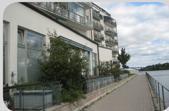
Smal bryggepromenade og rekkverk i glass gjør at man føler at man nærmest går på noens veranda
