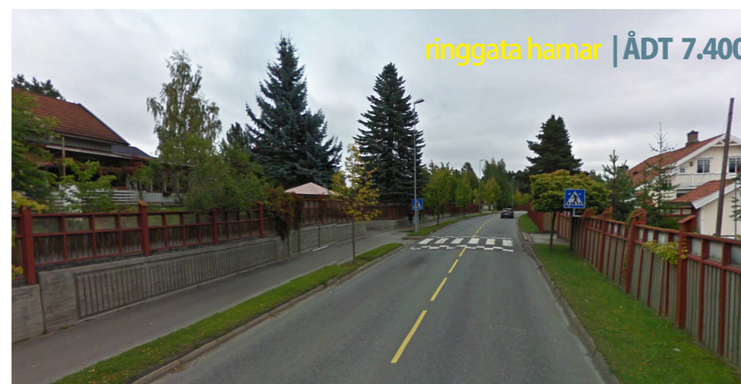
Figur 1.16. Dette eksemplet viser Ringgata i Hamar. Situasjonen er et eksempel for utforming av den nye ringgata i Elverum gjennom boligområder. Veien forbi Glomdalsmuseet er forventet å få en ÅDT på 5.500. Bildet til venstre viser en stram gate med ensidig fortau, kryssing i plan og støyskjermer. Skjermene mykes opp av vegetasjon foran, bak og hengende over.
