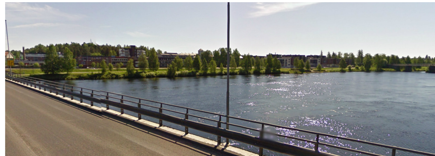
Figur 3.6. Elvefronten sett fra vestsiden og Glåmbrua. Rådhusstårnet bak trærne i Elvarheimsparken midt i bildet.
