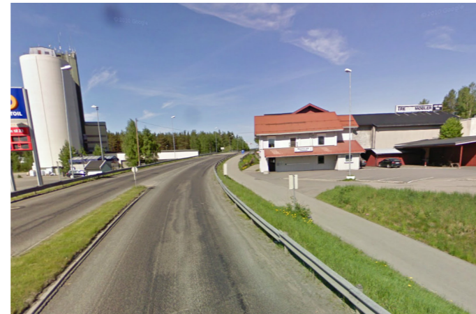
Figur 2.10. Den brede riksveien leder opp på fylling før den krysser jernbanen over bru. Kulvert under veien kommer opp til høyre.
