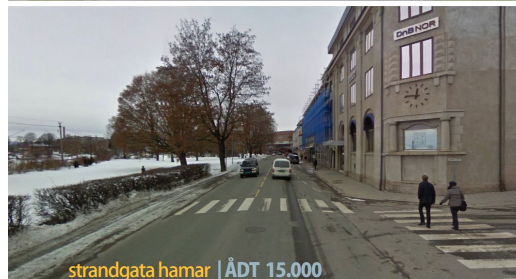
Figur 1.17. Til venstre vises et eksempel som kan virke mer overførbart til Elverum. Strandgata i Hamar, med 15.000 i ÅDT, fortau, gateparkering og kryssing i plan for myke trafikanter. Rv. 20 og rv. 25 gjennom Vestad og langs Glomma i Elverum bør også få fotgjengeroverganger og påkoplingspunkter med innkommende gater.
