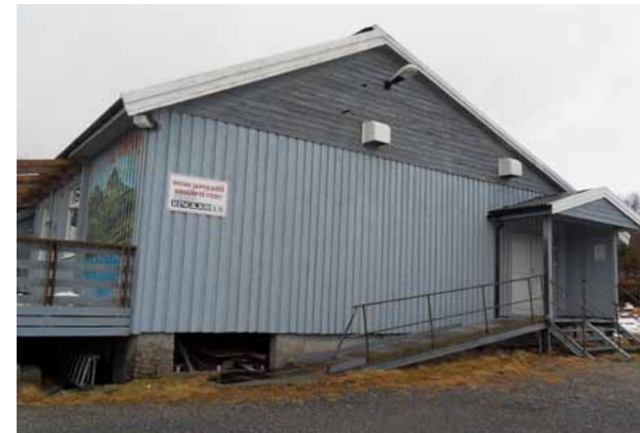
INNGANGSPARTIET: UNIVERSELL UTFORMING
