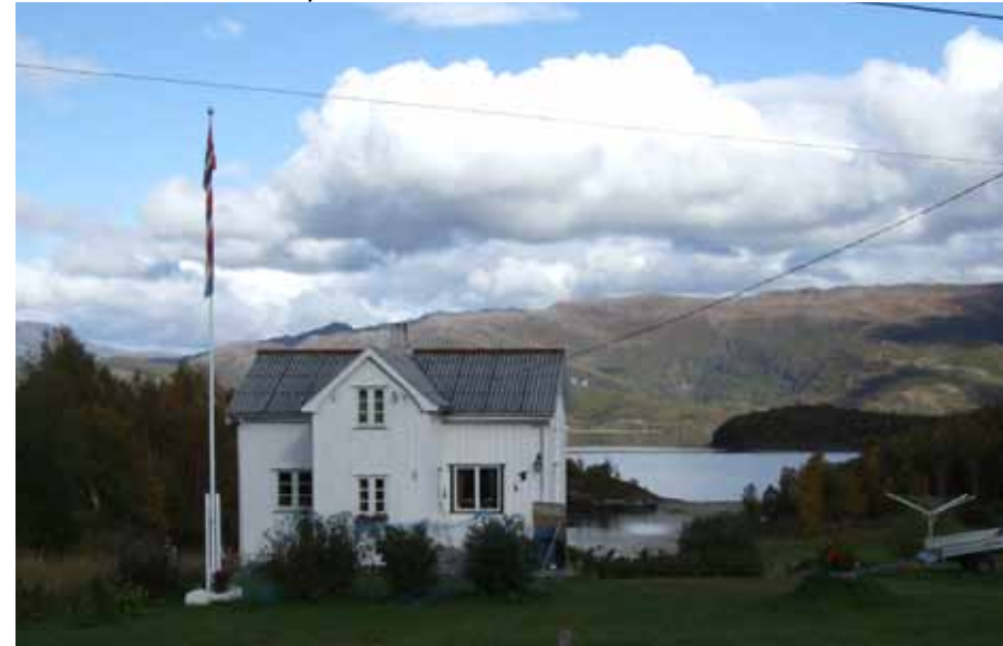
DEN ELDRE BEBYGGELSEN I SØRFJORDEN ER FISKERBONDEBRUK: NORDLANDSHUS MED MINDRE DRIFTSBYGNING I ENKELTTUN
