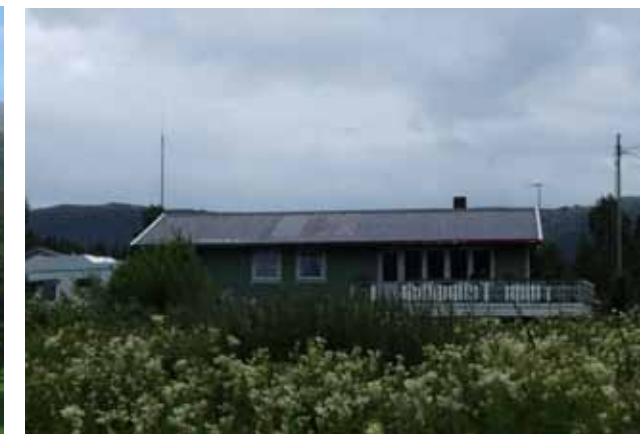
NYERE FERDIGHUS VED SEIVÅGEN: HELÅRSBOLIG
