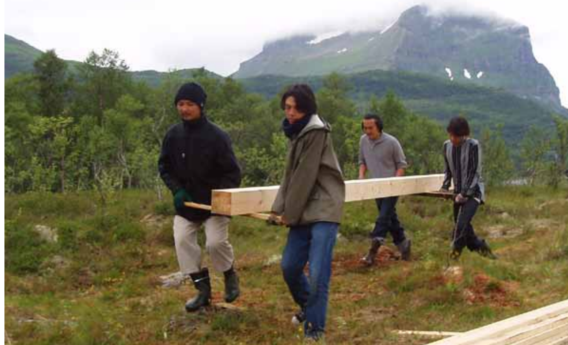
MEST MULIG AV MATERIALENE BLE BÅRET INN OVER MYRA TIL BYGGEPLASSEN FOR Å HOLDE SLITASJEN PÅ OMRÅDET SÅ LITEN SOM MULIG, HER STOLEPENE I HOVEDKONSTRUKSJONEN
