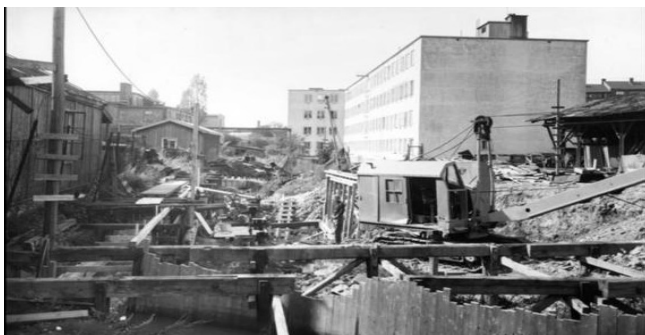
Figur 42: Lukking av Hovinbekken ved Ensjø i 1959 (oslobilder.no)
