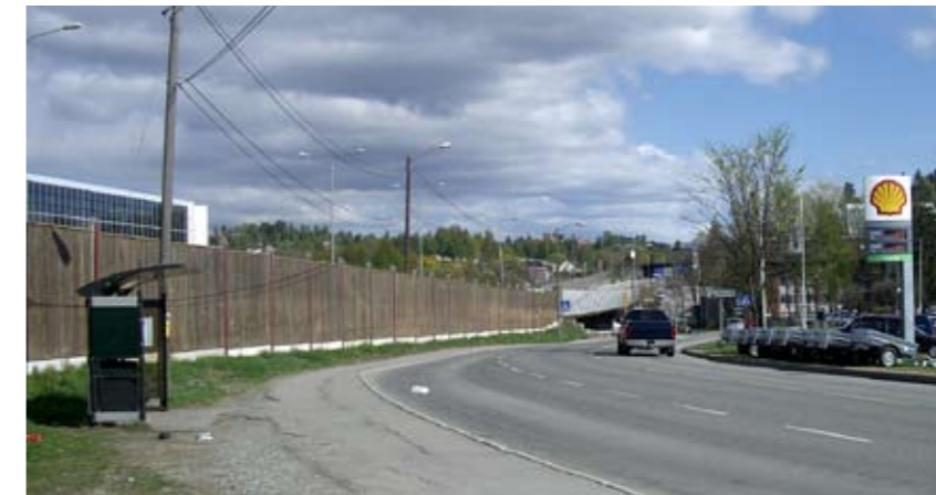
ANDRE FORHOLD: STØYSKJERM OG MOTORVEI. I horisontalkurven ved avkjøringen til Nesbruveien vil profilalternativ 2b sterkt berøre denne støyskjermen og motorveien som ligger bakenfor. Det må vurderes å redusere svingradiusen og flytte gateprofilen lenger østover.
