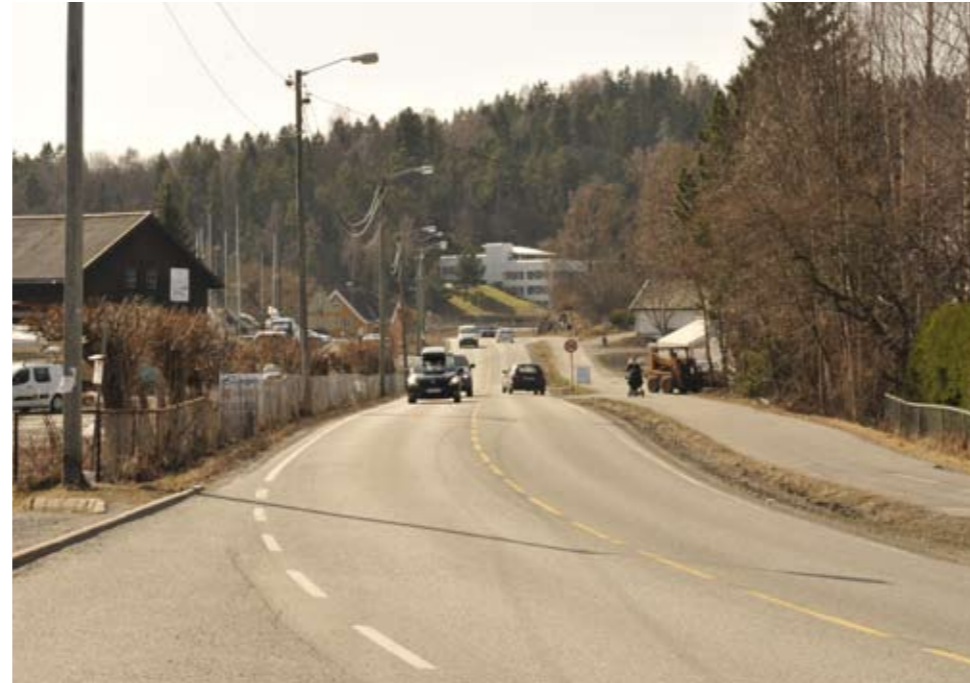
FEKJAN MOT SØR. Bildet er tatt midt på dagen i bussholdeplassen ved avkjøringen til Landsyveien. Holmensenteret skimtes i enden av veien med Grønolia i bakgrunn.
