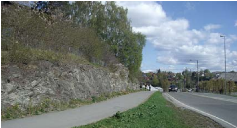
LANDSKAPSBILDET: FJELLSKJÆRING VED HOLMENGATA. Langs vestsiden av horisontalkurven til Fekjan vil denne fjellskjæringen ytterligere beskjæres med et utvidet profil. Det må vurderes å legge profilalternativ 2b lenger østover, inn på Holmen Slipp as sine arealer.
