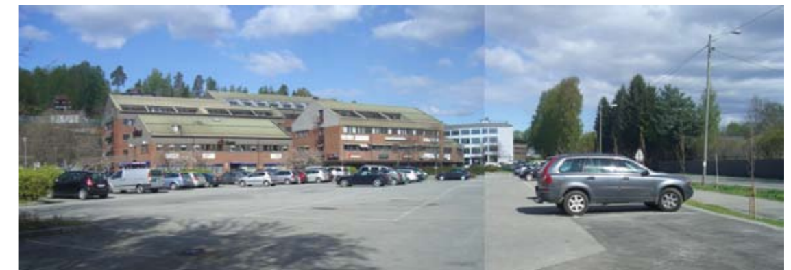
4. NESBRUSERET. Er et næringsområde med mange kontorer og enkelte butikker. Det ligger i mellom E18 og Fekjan. Området bærer preg av mye bilparkering og asfalterte flater.
