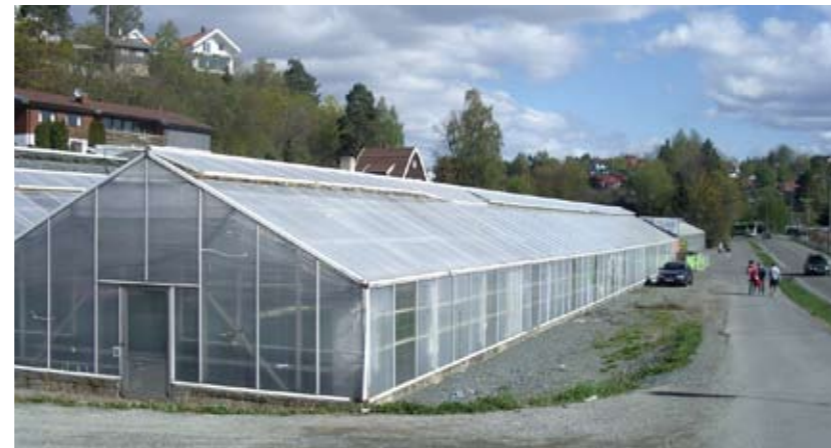
ANDRE FORHOLD: BERØRT DRIVHUS. Dette drivhusanlegget vil bli direkte berørt av profilalternativ 2b. I den kommende kommunedelplanen for området er dette arealet fått formålet «fremtidig bebyggelse». Denne bebyggelsen må virke gateforsterkende på Fekjan.
