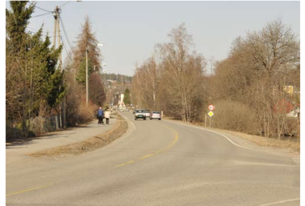
FEKJAN MOT NORD. Bildet er tatt i samme punkt som «Fekjan mot sør». Fylkesveien går svært rett i flere lengre distanser som gir god sikt. Støymuren til motorveien kan skimtes i enden av veien. Neselva ligger i grøntdraget langs veiens østre side (her høyre side).
