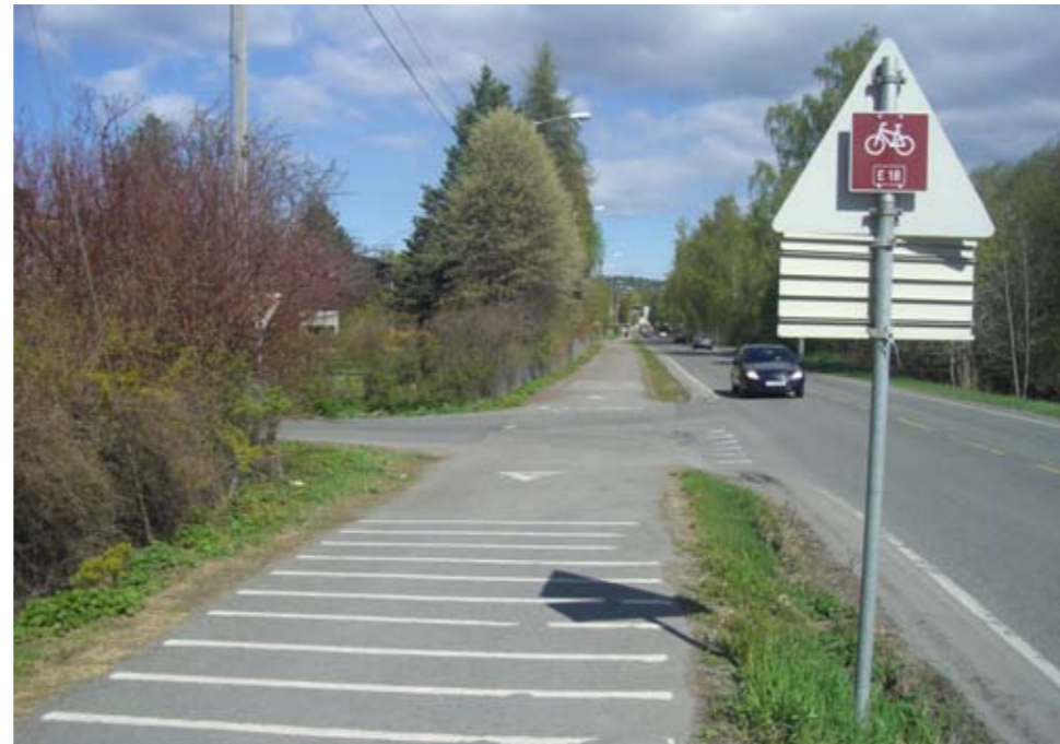
OPPBREMSING. Ved alle avkjøringer til boligveiene, som her ved avkjøringen til Langkroken, er det lagt «bremsriller» i gang- og sykkelveien. Høsten 2010 ble det gjort en ekstra innsats for å skilte gang- og sykkelveiene i Asker kommune.
