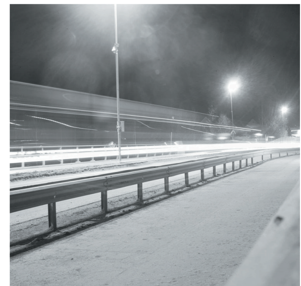
Rv25. Bildet tatt fra Åkersvika veikryss møt øst
