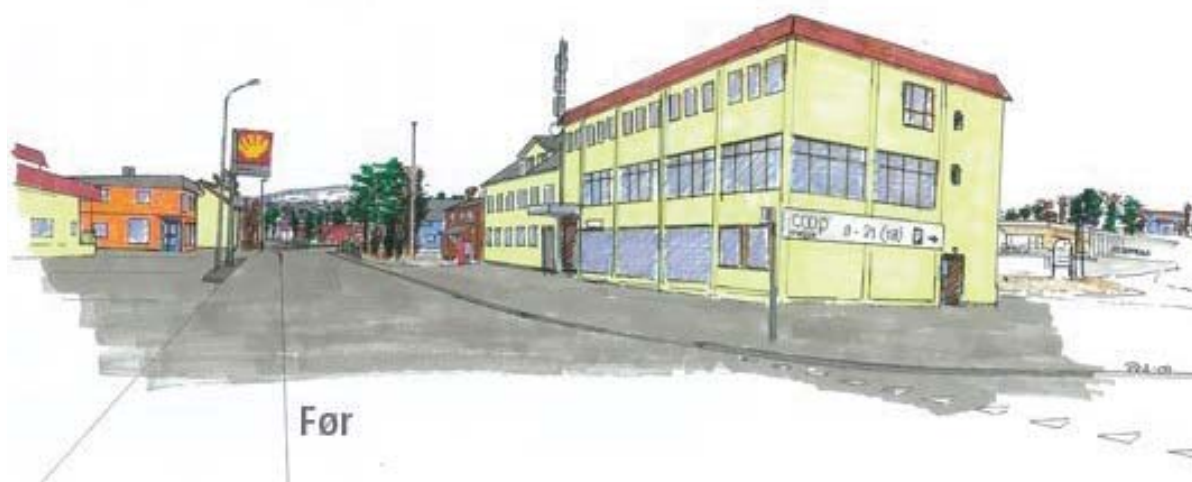
Fig. 4.21 Setermoen før oppgradering av gatenettet til Miljøgate (Statens vegvesen 2009b).
