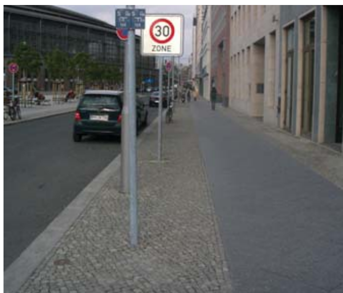
Fig. 3.12 Fortau med definert møblerings-, og ferdselssone på bakgrunn av forskjell i belegg (Vegdirektoratet 2009).
