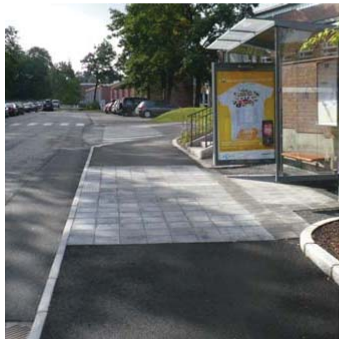
Fig. 3.15 Bussholdeplass med annet belegg for å markere holdeplassen. Det er etablert ledelinjer fra busskuret til bussens front dør (Vegdirektoratet 2010).
