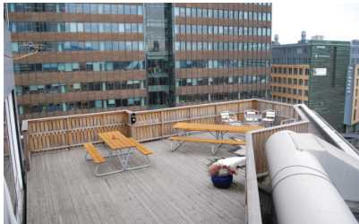
Illustration 76. Existerande terrass. Genom mötesrum 803 kan brukarna komma in och ut på terrassen.
