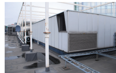
Illustration 82. Existerande konstruktion som ser ut att stötta delar av existerande installationer.
