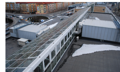
Illustration 83. Denna del av taket ligger lägre och har ett glastak som är upphöjt ovanför övrig takyta.
