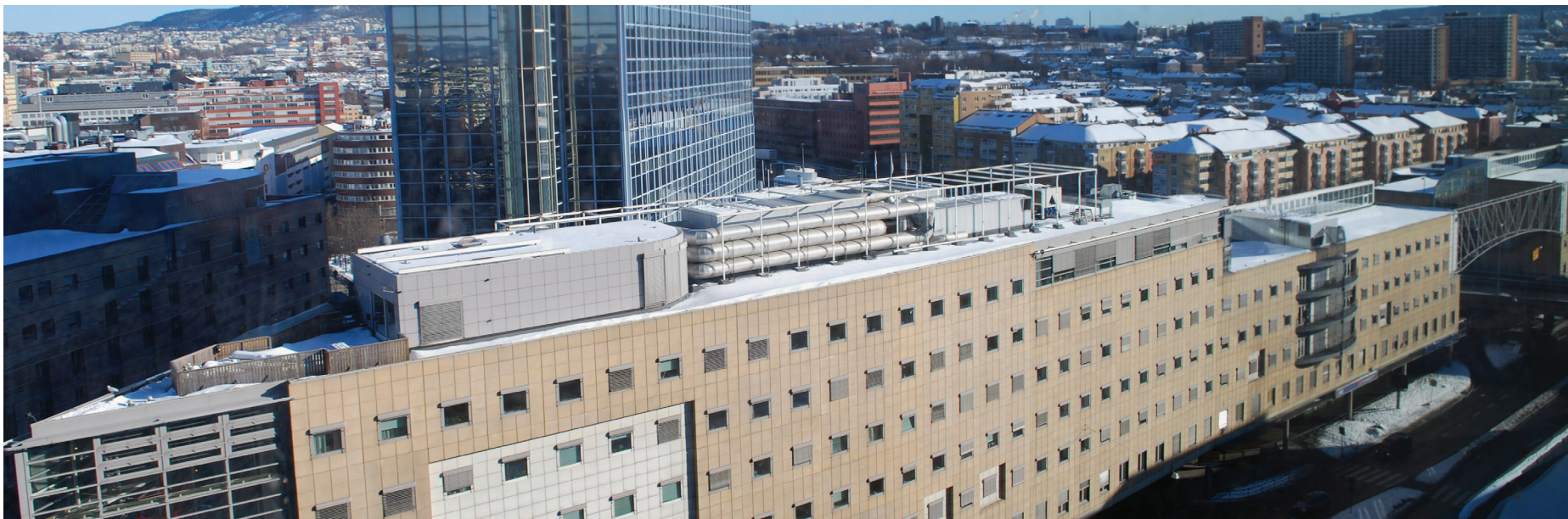
Illustration 62. Illustrationen visar den västra delen av Galleri Oslos tak. Bilden är tagen mot nordöst.
