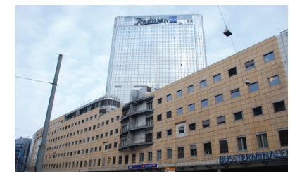
Illustration 75: Hotell Plaza i bakgrunden av Galleri Oslos södra fasad. Bilden är tagen från Schweigaards gate mot nordväst.
