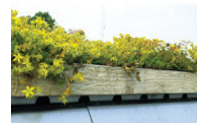
Illustration 137. Kantavslut behöver läggas på mötesrum 803 eftersom det där saknas takkant.
