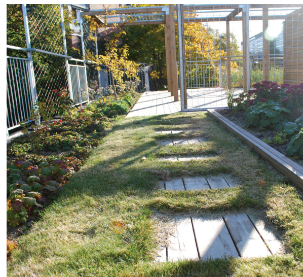
Illustration 97. Millennium Park, i Chicago. På världens kanske största intensiva gröna tak har ett brett spektrum av vegetation kombinerats.
