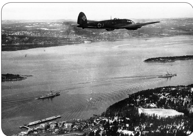
Norsk Brændselolje på Fagerstrand under 2.verdenskrig, legg merke til at raffineriet har kamuflasje malte tanker.
