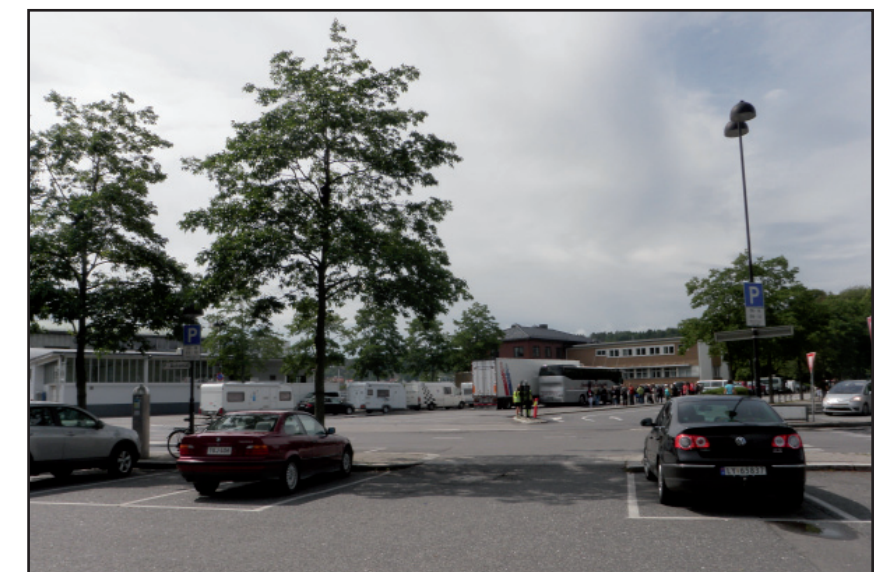
Store asfaltflater omkring ferjeanlegget.
