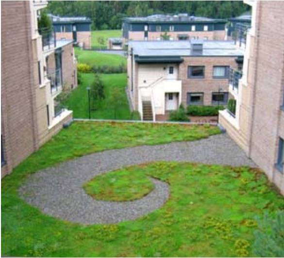
Bilde 34: Gjødset sedum ser mer frodig ut. Fossum terrasse, Bærum (Seim 2010).
