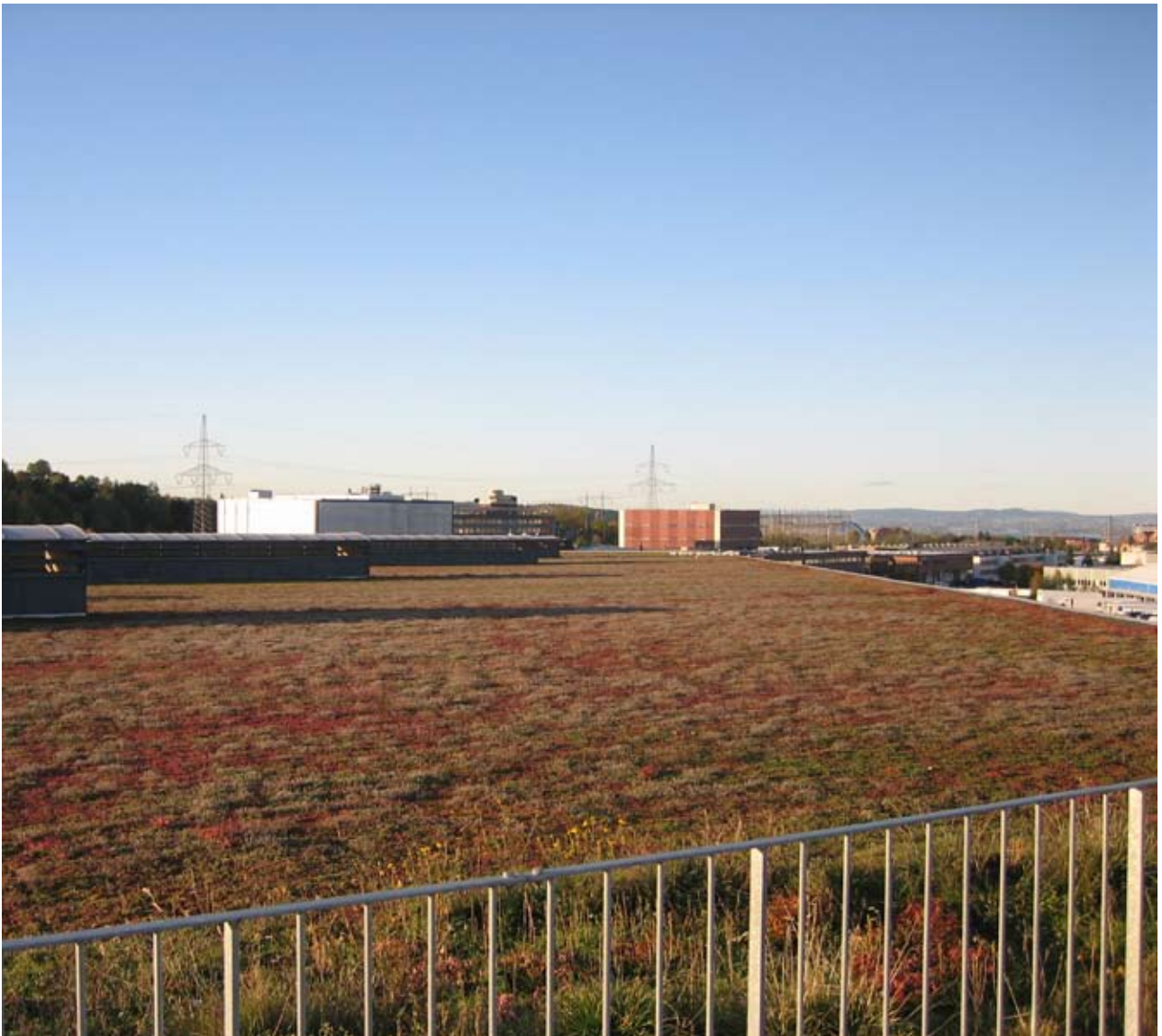
Figur 24b: Sedumdekket på Veolia i Oslo.
