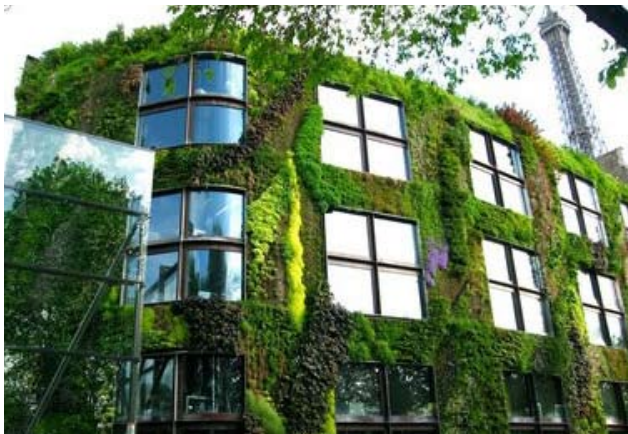
Figur 11: Grønn vegg i Quai Branly, Paris. På denne bygningen er det brukt flere forskjellige arter, men kun arter som eføy kan også brukes (Blanc 2010).
