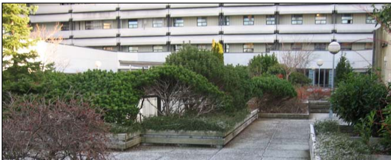
Figur 23: Takterrassen på Haukeland sykehus. Her kan vi se at det går sti mellom plantekassene.
