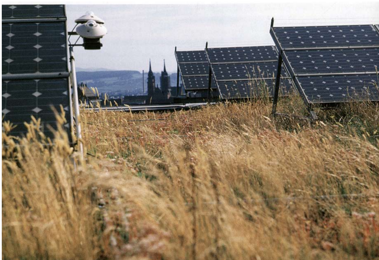
Figur 44: Solcellepaneler på beplantede tak kan øke produksjon av energi. Dette skyldes at solcellene trenger jevn temperatur. På mørke tak kan det fort være skiftende temperatur. På dagen er det varmt, men når solen forsvinner blir det straks kaldt. Ved bruk av vegetasjon vil denne temperaturforskjellen bli mindre og man unngår dermed store svingninger (Cantor 2008).
