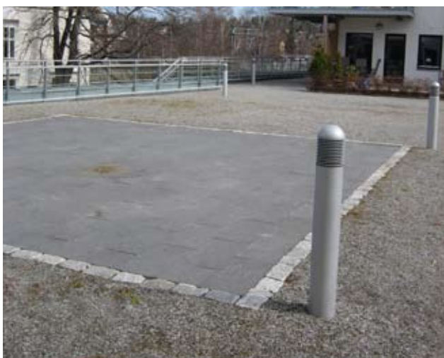
Figur 86: Dekke med betongheller og belysning.
