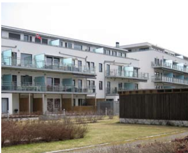
Figur 84: Åsheim bygg B og A kan virke noe dominerende, sett fra bygg C. Her kan vi også se at bygg A (lengst til høyre) er 1 etasje høyere enn bygg B
