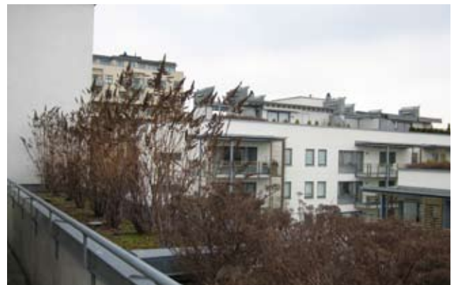
Figur 72: Takterrasse i Pilestredet Park.
