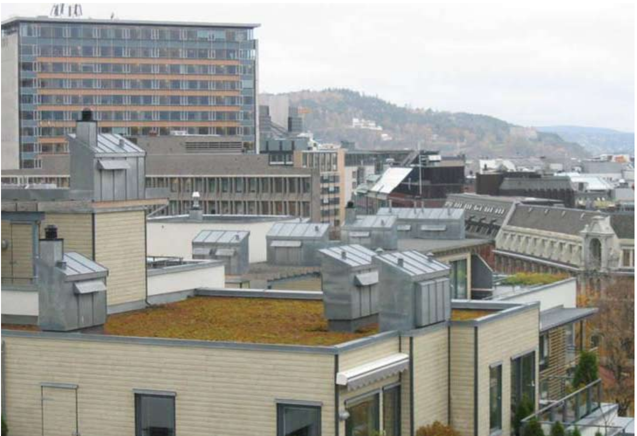
Figur 73: Oversiktsbilde som viser en av bygningen med sedum (Veg Tech 2008).
