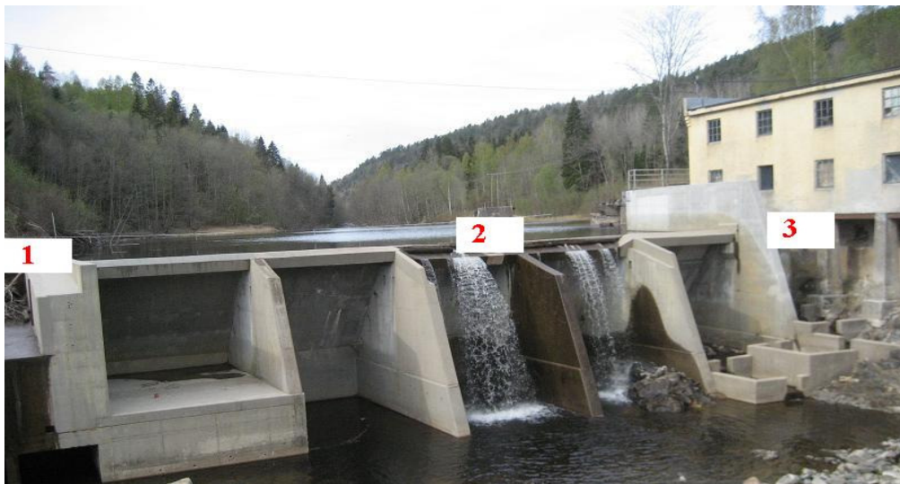
Fig. 10: Demningen ved Fosstveit kraftverk. 1: Rensekanal, 2: Damkrone, 3: Laksetrapp. Sideløpet er like utenfor bildet på venstre side.
