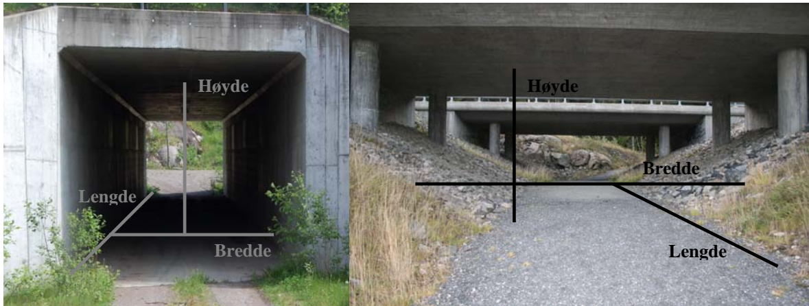
Figur 4. I underganger som i bildet til venstre er det trukket fra noen meter i bredden, hvor det er for lavt til at elg kan passere, i forhold til underganger som vist til høyre, der veggene er rette. Foto: V. Kristiansen og G. O. Strætkevren.
