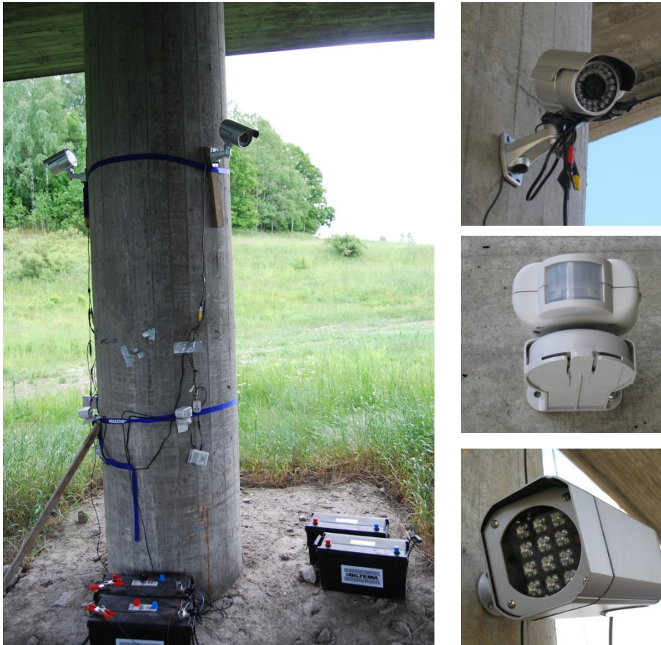
Figur 4. Til venstre et eksempel på oppsett av videoovervåkningssystemet fra undergangen på Støkken (Foto: Jo Trygve Lyngved). Ekstra IR-lys er ikke synlig på bildet. Til høyre nærbilder av kamera (øverst), sensor og ekstra IR-lys (Foto: Ronny Steen).
