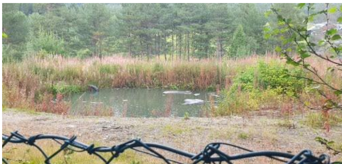
Figur 7-11: Infiltrasjonsbasseng ved Lesjaverk renseanlegg. (Foto: privat)
