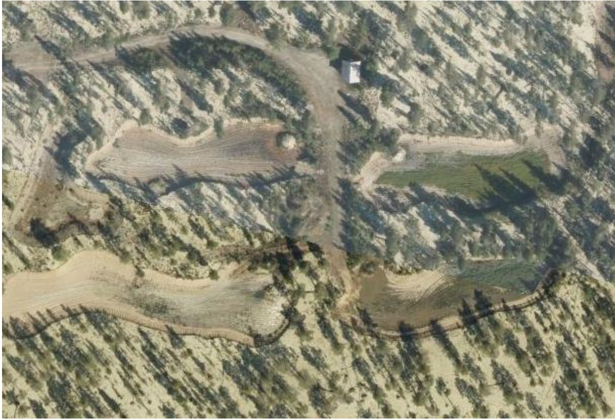
Figur 7-2: Flyfoto over det største renseanlegget i Folldal. Bildet viser 4 åpne infiltrasjonsbasseng. © (Kartverket, 2023)
