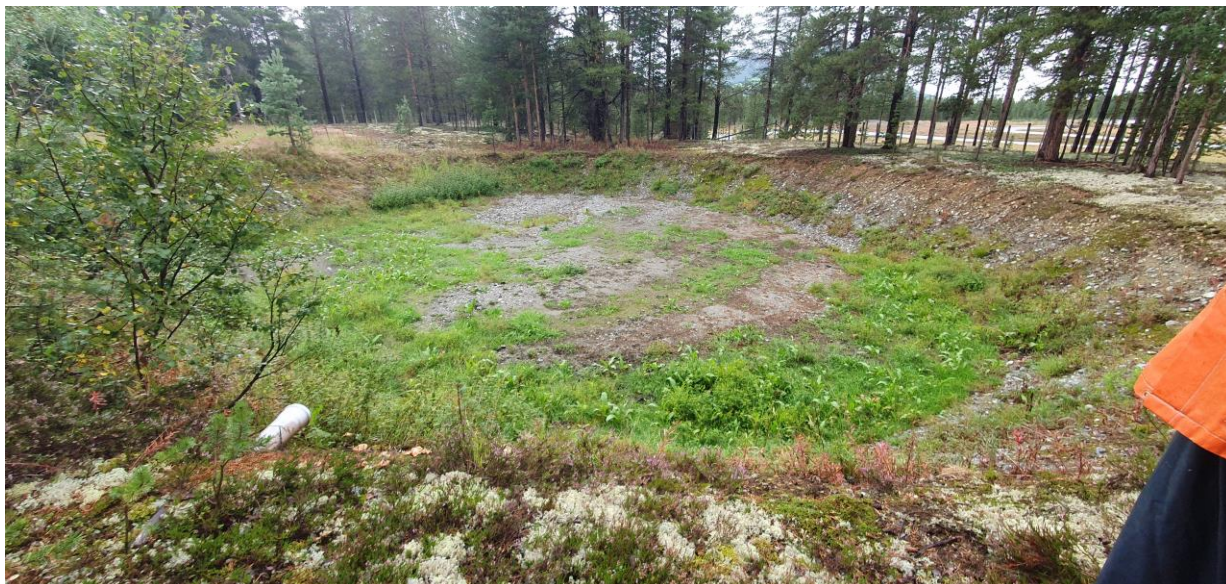
Figur 7-20: Overløpsbasseng på Bjorli (Foto: Privat)
