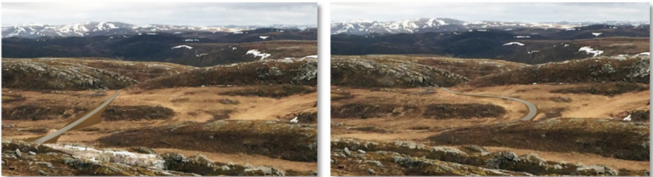
Figur 3.18 her illustreres to eksempler på veillinje, der den rette linjen til venstre bryter med terrenngformene og dermed blir mer fremtredende i landskapet (Multiconsult, 2019,Håndbok).
