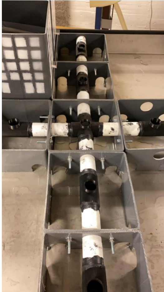
Figur 14: Lekkasje-reducerende tiltak, som liming av rørkoblinger og skru sammen moduler.
