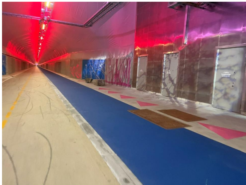
Figur 6. Det er lagt ned mye innsats i lysdesign og fargebruk i tunnelen. Til høyre er gummidেকে for gående, og til venstre er sykkel felt. Foto: forfatter.
