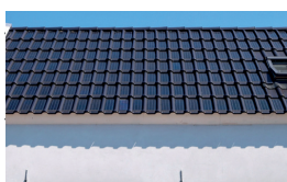
FIGUR 1: VISER SOLCELLE FORMET SOM TAKSTEIN
