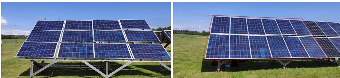
Figur 3.2: Solcellemodulene på Søråsjordet. Til venstre vises det nordlige anlegget, der modulene er installert horisontalt. Til høyre (innenfor den røde firkanten) vises det søndre anlegget, der modulene er installert vertikalt. Bilder fra M. Jokovljevic (personlig kommunikasjon, mars 2023).
