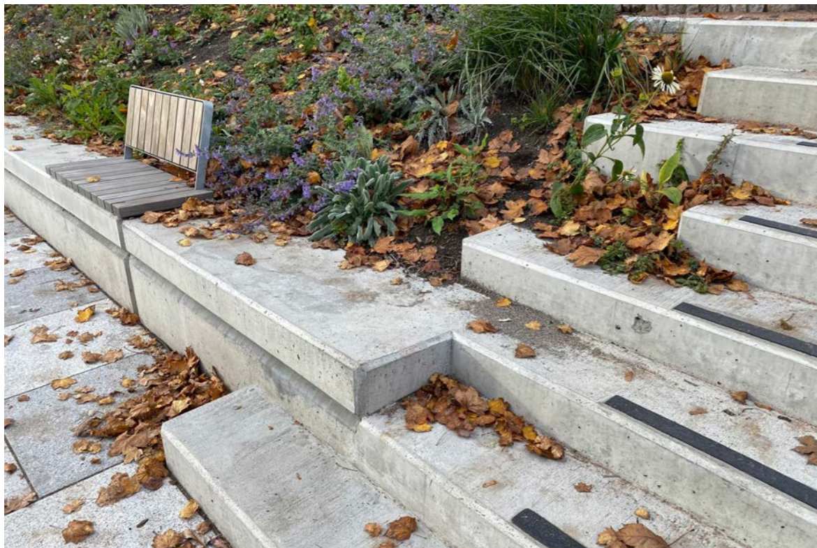
Figur 9: Dynamisk trapp og beplantning i Sommerparken på Solli plass i Oslo, designet av SLA Norge (Andersen, 2022).
