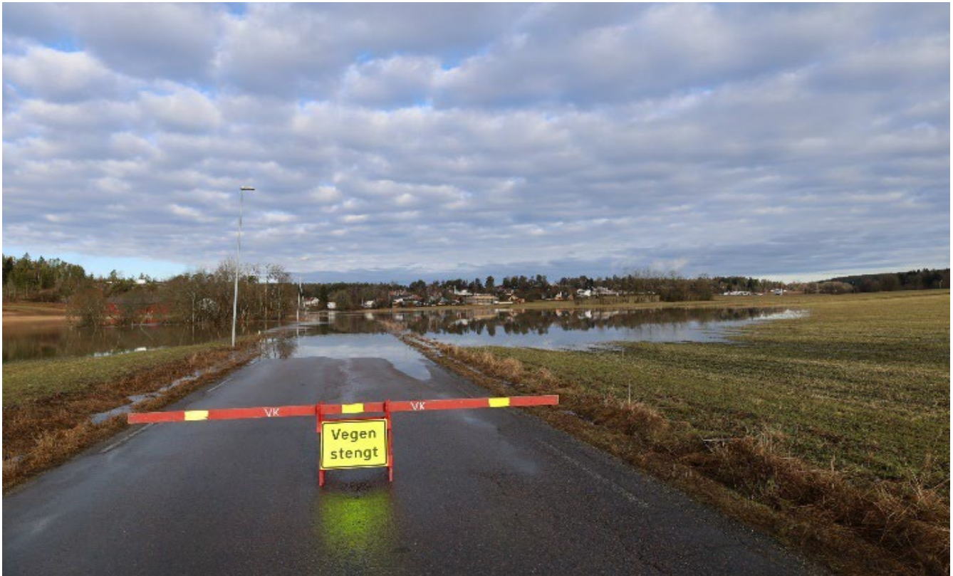
Bilde 6: Kongeveien i Hølen som er stengt på grunn av store mengder vann etter flomhendelse 15.02.2022. Foto: Emilie J. Godal
