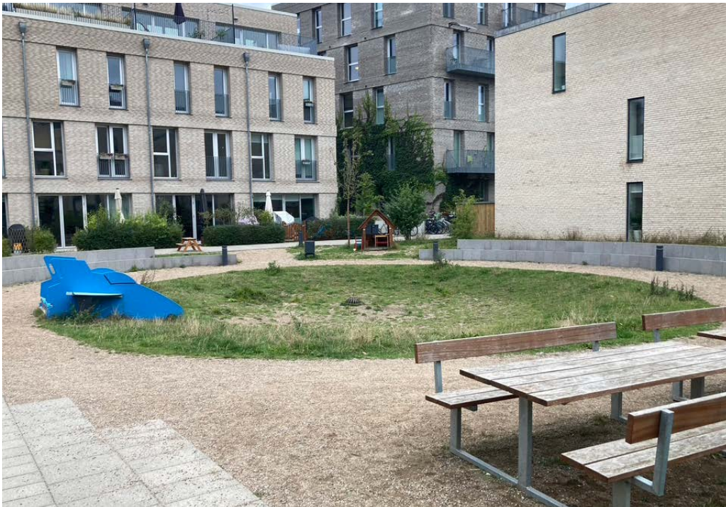
Figur 2: Overvannstiltak som lekeplass
