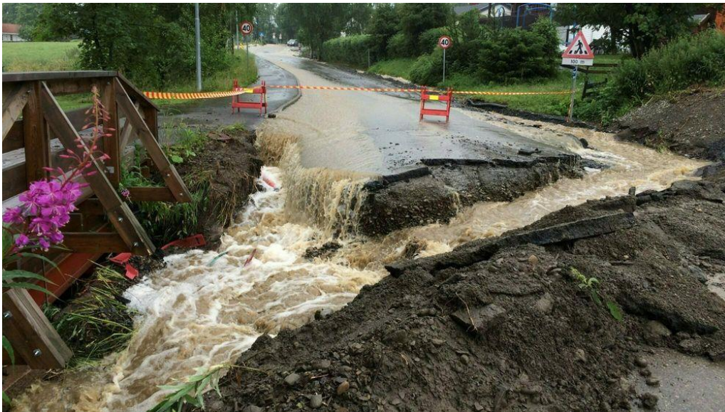
Figur 2: Overvann og flom. Foto: Grete Hedemann Aalstad, NVE.
