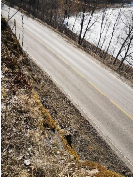
Figur 24 Bilde rett ned mot Sørkedalsveien fra kanten til skråningen. Foto: Mai Yan Brask
