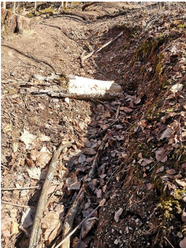
Figur 33 Erosjonsskade på vei ned til badeplassen. Foto: Mai Yan Brask.
