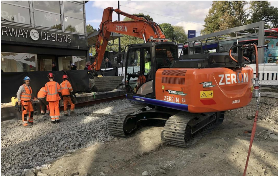
Figur 7: Elektrisk gravemaskin i bruk i anlegget i Olav Vs gate (Bymiljøetaten, 2020).
