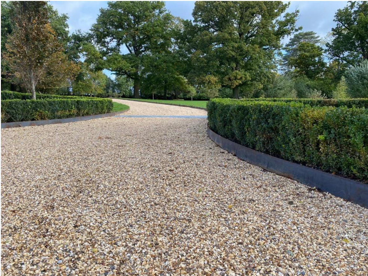
Figur 2: Kantar av rustfritt stål på eit anlegg i England
