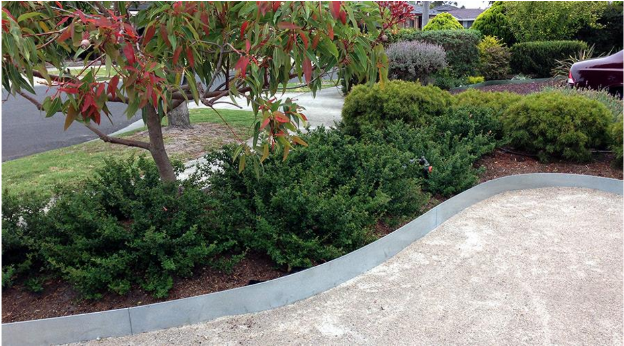
Figur 3: Kantar av galvanisert stål i ein hage i Australia
